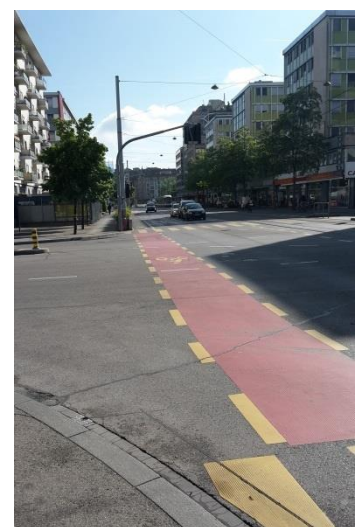
Figure 11 – Marquage rouge pour signalisation conflit
