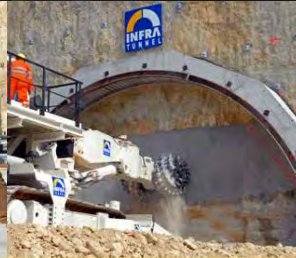
Début de l'excavation de la calotte du tunnel Nord de Serrières, portail d'Auvernier, 23 mars 2009.
