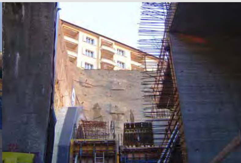
A Serrières, la liaison entre le tunnel et la tranchée est bétonnée au pied des immeubles.
