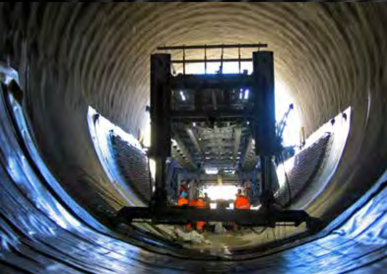
Etanchéité et coffrage du radier.
