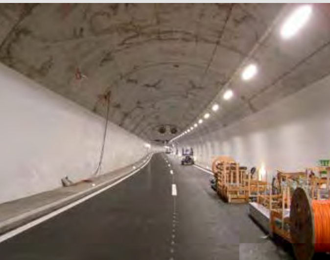
Pose de l'éclairage de traversée à LED (à gauche) avec l'éclairage de chantier (à droite). Bobines de câbles pour l'alimentation des luminaires.
