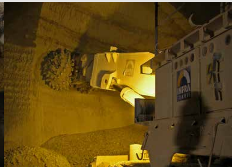
Excavation de la calotte.
