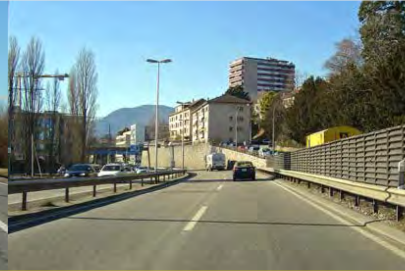
La N5 à Serrières avant travaux, février 2008.
