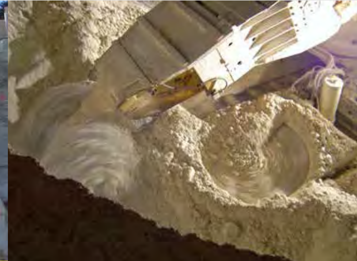
Excavation du stross.
