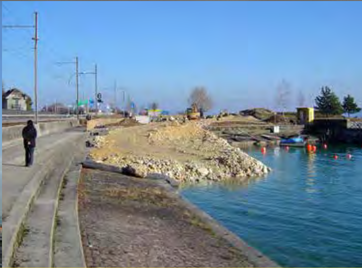
Remblayage provisoire du port de Serrières pour permettre la déviation du tram et du trafic sur l'ancienne emprise du Littorail.
