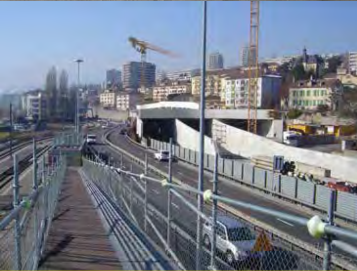
Le tram est déplacé au Sud de la gare TransN, sur le remblai provisoire du port, permettant la déviation des voies autoroutières. Leur largeur réduite est dictée par l'espace entre la gare et le mur de la tranchée.
