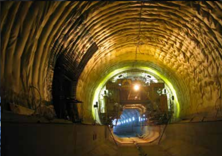
Etanchéité et coffrage de la voûte.
