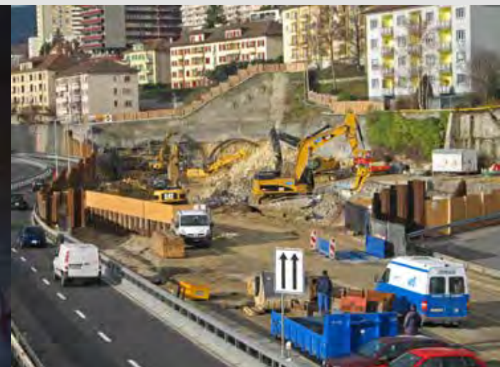
A Serrières, le terrassement a été réalisé en automne pour ne pas perturber les riverains. Pour limiter la durée des nuisances, le nombre de machines a été augmenté.
