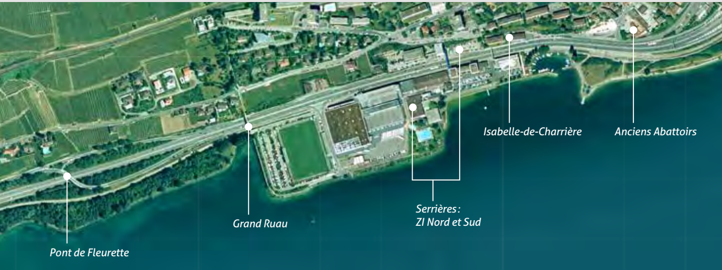
Situation avant travaux (Orthophoto 2004).
