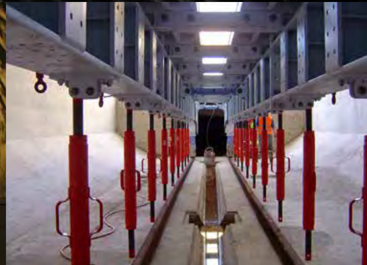
Coffrage de la GAT.
