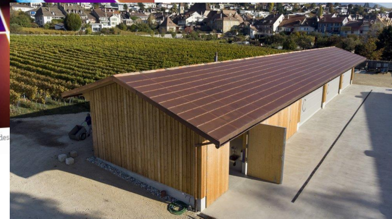
Grand toit solaire, Château d'Auvernier
