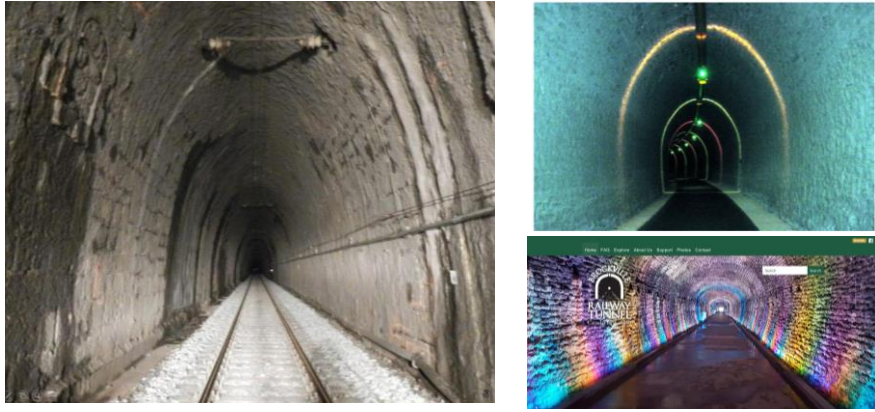
Figure 7– Tunnel des Loges (gauche) et exemples de valorisation (droite, en haut : tunnel des Comps (FR), en bas : tunnel de Brockville (CN))
