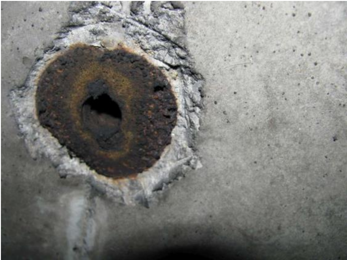
Extrémités inférieures des suspentes du faux-plafond
