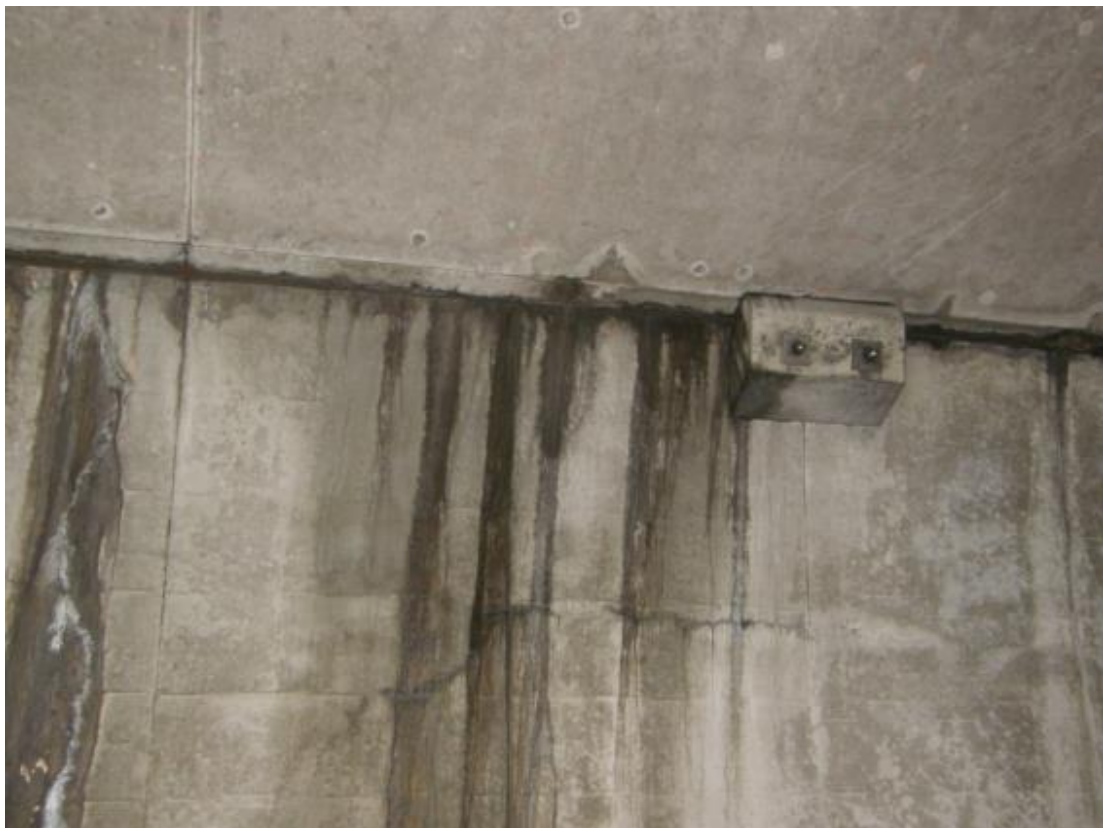
Corbeau d'appui de la dalle intermédiaire ajouté en 1999.
