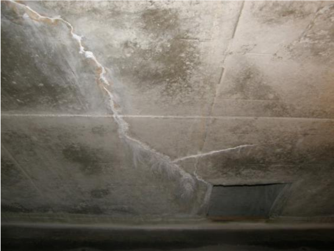
Corbeau d'appui de la dalle intermédiaire ajouté en 1999.
