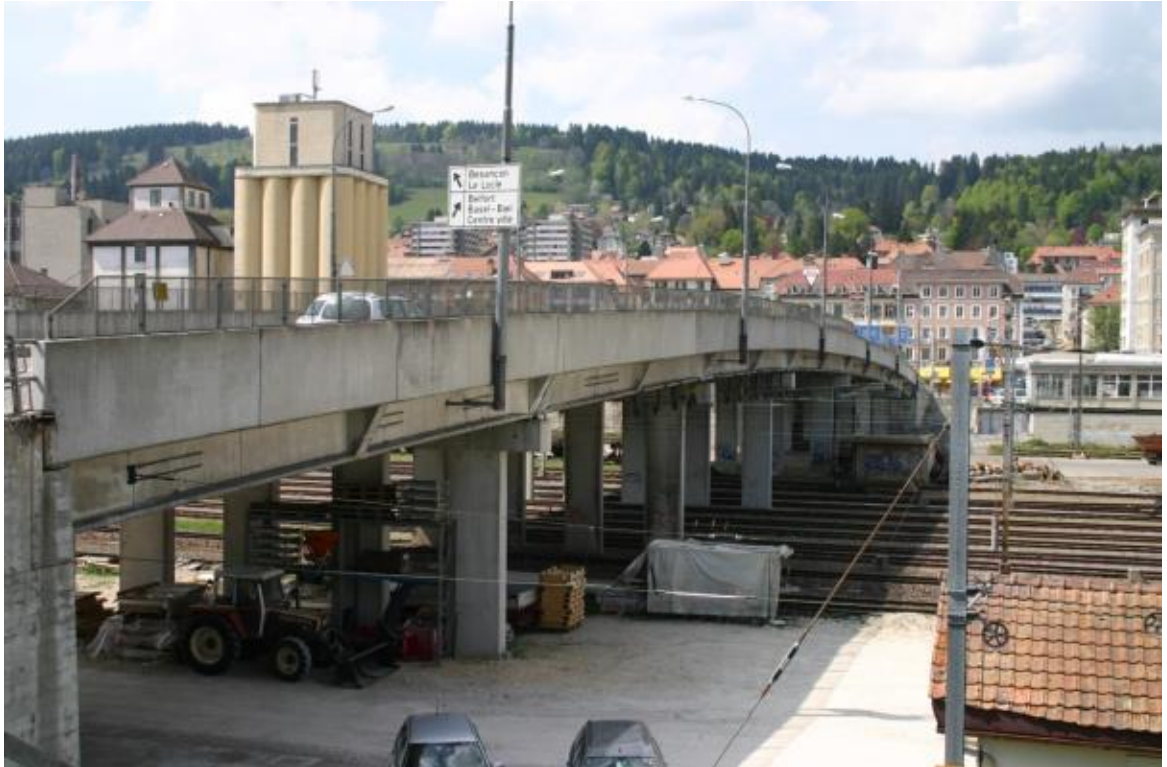
Vue d'ensemble du pont.
