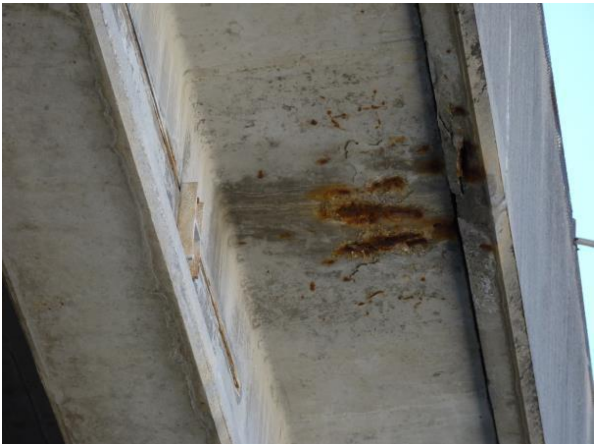
Vue de dessous du tablier avec parapet.
