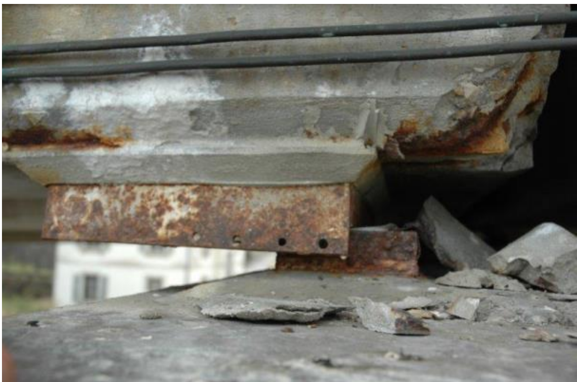
Appui sur 30 mm dû à l'excentricité extrême.
