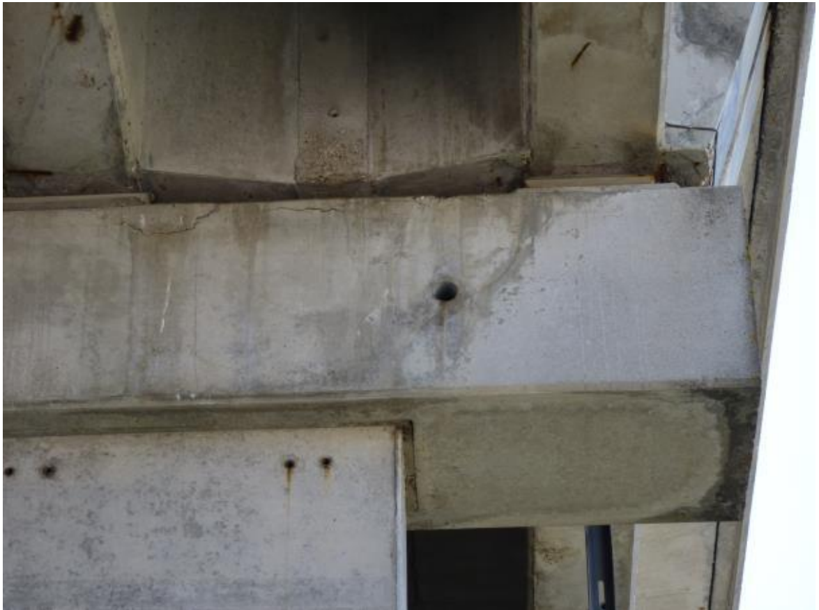
Vue sommier, pile et poutres.
