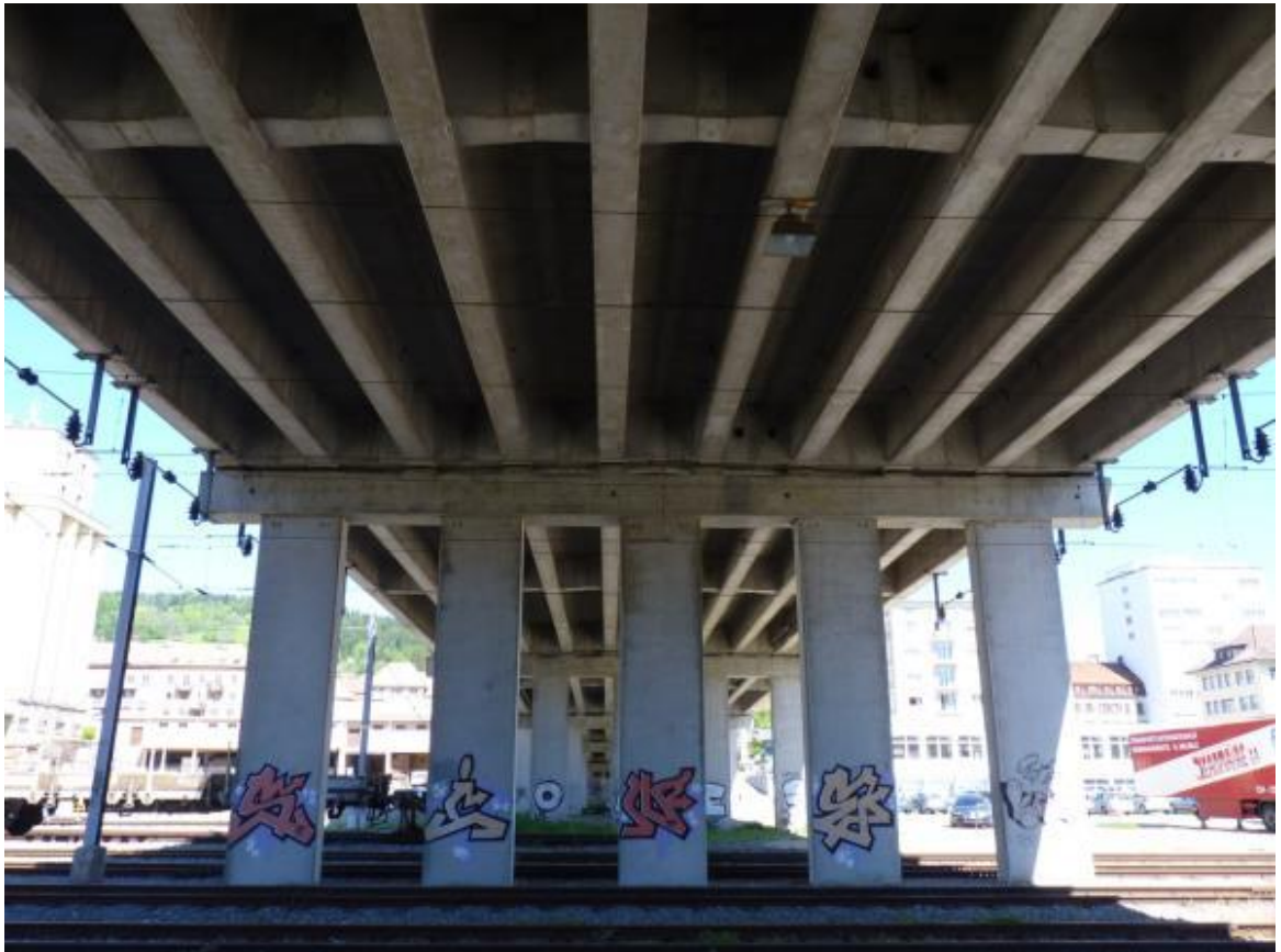
Vue sous le pont.
