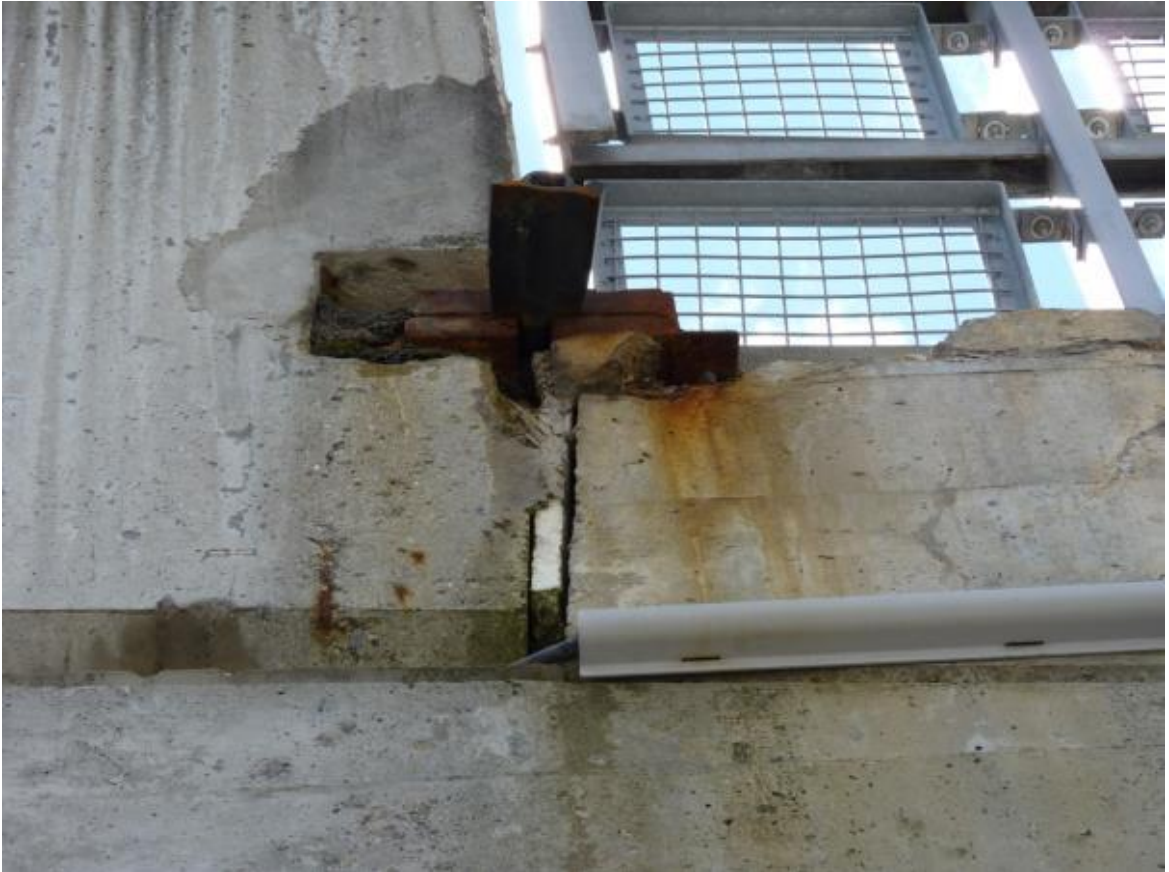
Vue au joint de chaussée
