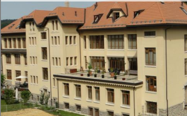
Chaux-de-Fonds : lofts industriels
