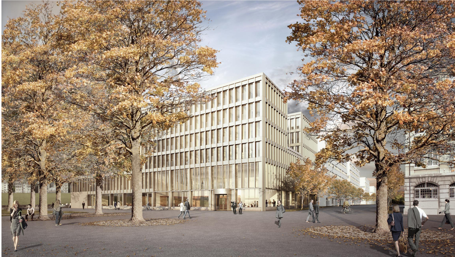
Nouvel Hôtel Judiciaire : le Nouvel Hôtel Judiciaire sur la place de la gare à La Chaux-de-Fonds (source : Isler Gysel Architekten, Zürich).
