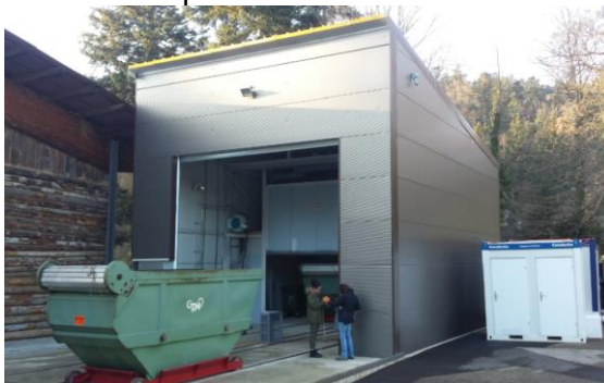
Installation provisoire chambres froides SCAV
