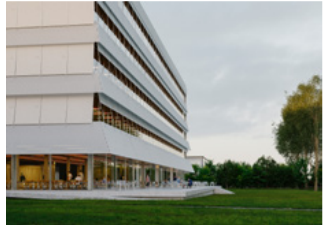
Vue du sud-ouest : voiles et bardage des façades reflètent les besoins en lumière naturelle et font écho à une architecture navale.
