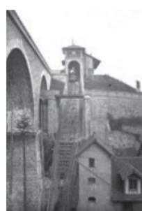
A partir de 1892, un funiculaire, appelé plan incliné, reliait le fond du vallon à la gare et permettait d'envoyer la production de chocolat et de papier en Suisse et en Europe. Il a été démolie en 1954. Un étonnant réseau de rail Décauville (à voie étroite) permettait en outre à des wagonnets de transporter les marchandises entre les différentes usines.
