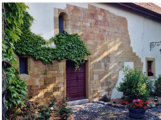
Bevaix, façade est de l'ancienne abbaye : les pierres jaunes situées au dessus de la porte sont rubéfiées. Photo B. Rousset, 2002
