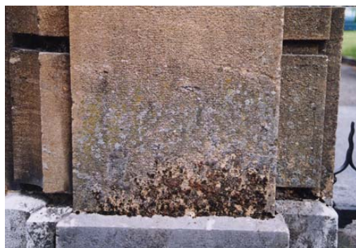
Neuchâtel, faubourg de l'Hôpital, 68 : dans la frange capillaire se répartissent les algues et les lichens (jaune, gris vers le haut) et les mousses (à la base). Photo B. Rousset, 2002
