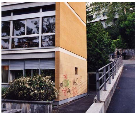
Neuchâtel, Ruelle Vaucher, Lycée Denis de Rougemont : le pan inférieur est très nettement blanchi par un traitement antigraffiti. Photo B. Rousset, 2002
