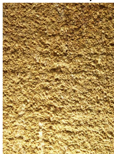
Faubourg du Lac, 13 Hydrogommage "plus doux"
