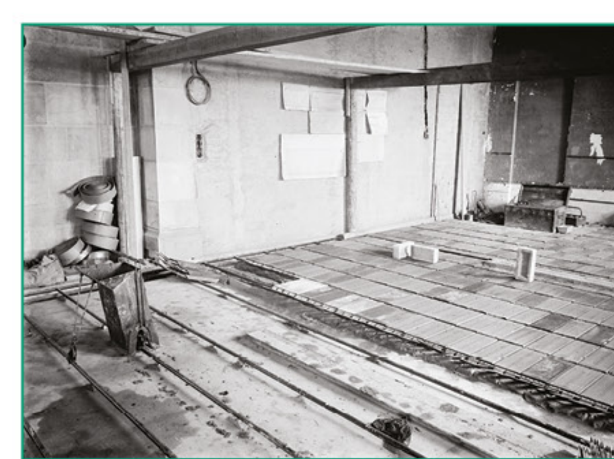
Au début du 20 e siècle, la coexistence d'une technologie contemporaine avec la conservation des éléments anciens est à l'ordre du jour, à l'image de la nouvelle dalle en béton armé coulée dans la salle des Chevaliers en 1925 ou des distributeurs du chauffage au sol posés en 1934 dans la galerie Philippe-de-Hochberg. (OPAN, fonds ISCP n°3052 et n°3680)
