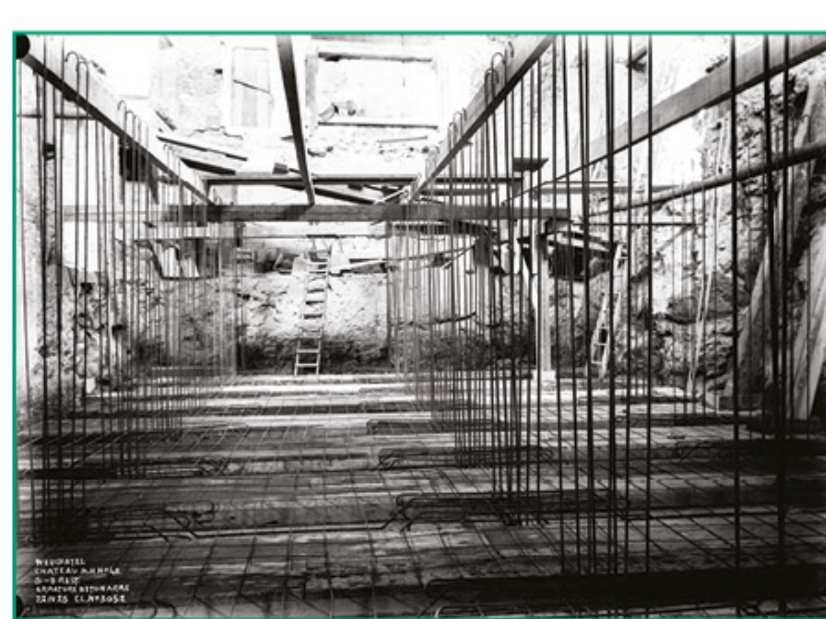
Au début du 20 e siècle, la coexistence d'une technologie contemporaine avec la conservation des éléments anciens est à l'ordre du jour, à l'image de la nouvelle dalle en béton armé coulée dans la salle des Chevaliers en 1925 ou des distributeurs du chauffage au sol posés en 1934 dans la galerie Philippe-de-Hochberg. (OPAN, fonds ISCP n°3052 et n°3680)
