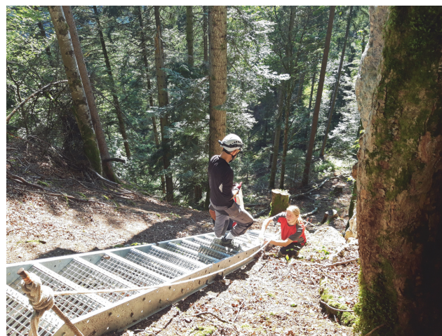
Figure 11. Escaliers métalliques installés sur le talus qui mène à la grotte. (Cliché : OPAN, section Archéologie)
