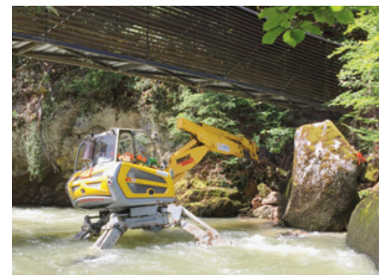
La pelle rétro en action sous la passerelle. SP-JEAN-CLAUDE CHAUTEMS
