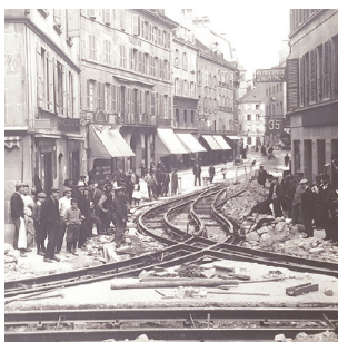
La pose des rails du tramway en 1910
