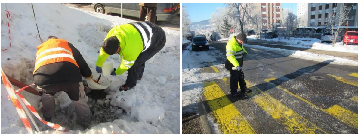
Photos : Injection du traceur le 22 janvier à 10h40 et dispersion de stop-gliss sur les plaques de glace qui se sont formées suite aux fuites d'eau aux raccords des tuyaux.
