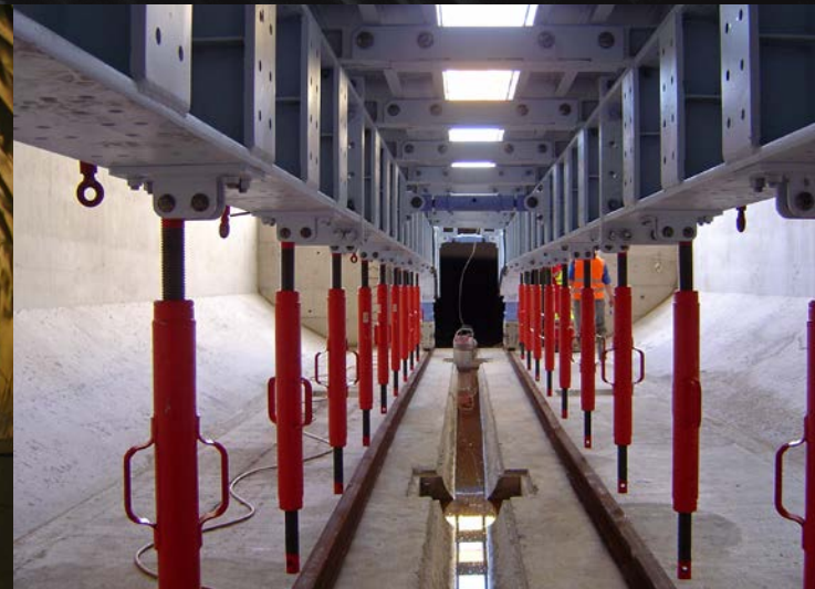
Coffrage de la GAT.
