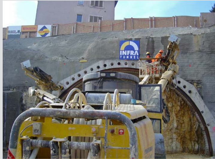
Première étape de voûte parapluie au portail du tunnel Sud à Serrières.
