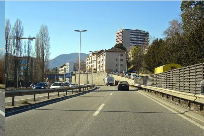
La N5 à Serrières avant travaux, février 2008.
