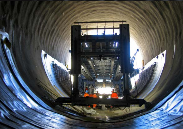
Etanchéité et coffrage du radier.
