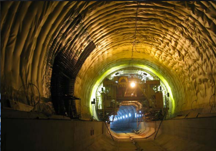
Etanchéité et coffrage de la voûte.
