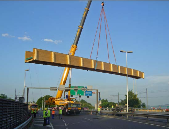
Mise en place de la passerelle provisoire, restituant l'accès piétonnier à la gare du Littorail et aux rives.
