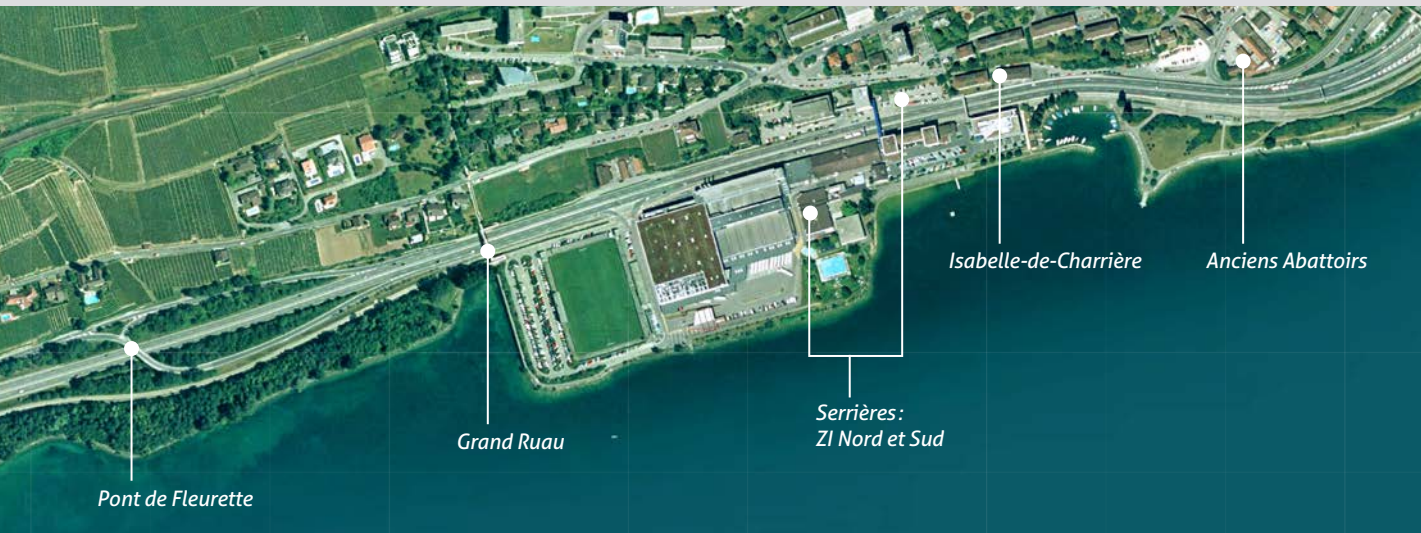
Situation avant travaux (Orthophoto 2004).
