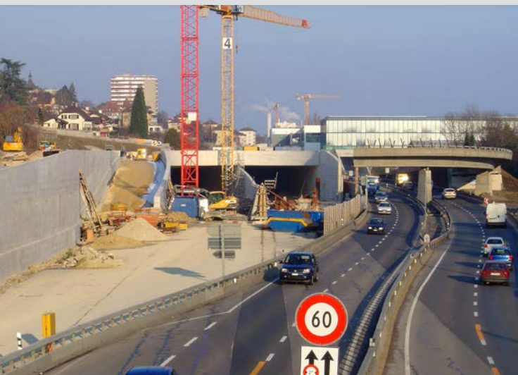
Proximité des voies en service à Auvernier: les voies en direction de Lausanne seront, dans une phase ultérieure, déviées par-dessus la tranchée de façon à pouvoir terminer la construction des murs Sud et central, ainsi que la chaussée autoroutière.
