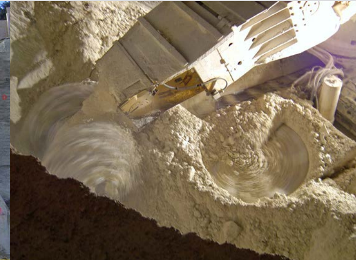
Excavation du stross.
