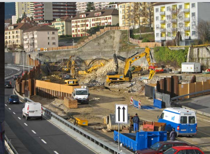
A Serrières, le terrassement a été réalisé en automne pour ne pas trop perturber les riverains. Pour limiter la durée des nuisances, le nombre de machines a été augmenté.
