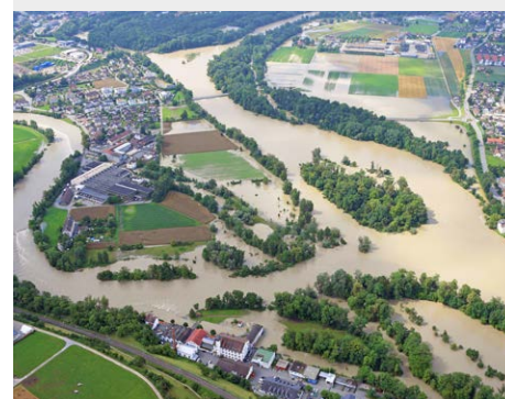
Près de Brugg (AG), l'Aar, la Reuss et la Limmat se rejoignent pour former le « château d'eau ». Malgré les débordements observés en juillet 2021, la région n'a pas subi de dommages notables grâce aux mesures de protection mises en place après les crues de 2005 et 2007.
