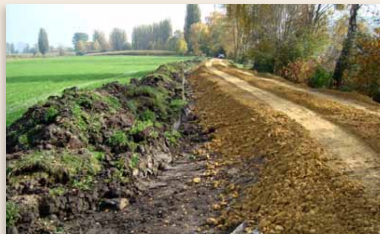
Réhaussement partiel de la berge neuchâteloise de la Thielle (2008-2009)
