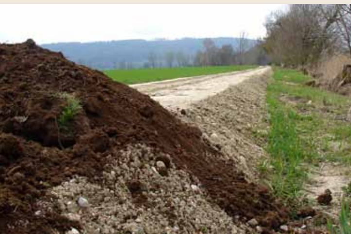
Réhaussement partiel de la berge nord-est de la Vieille Thielle (2009-2010)
