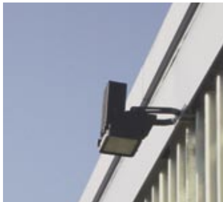
Pas de lumière inutile diffusée directement vers le ciel – pour autant que la lampe soit orientée du HAUT vers le BAS.
