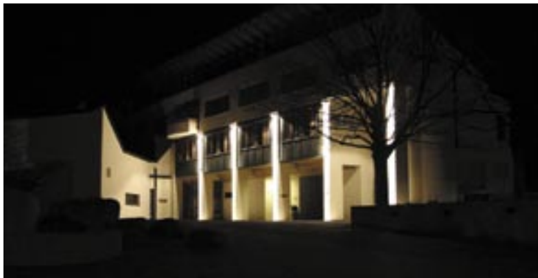
Orientation correcte du HAUT vers le BAS, qui accentue l'éclairage du sol et de la façade.
