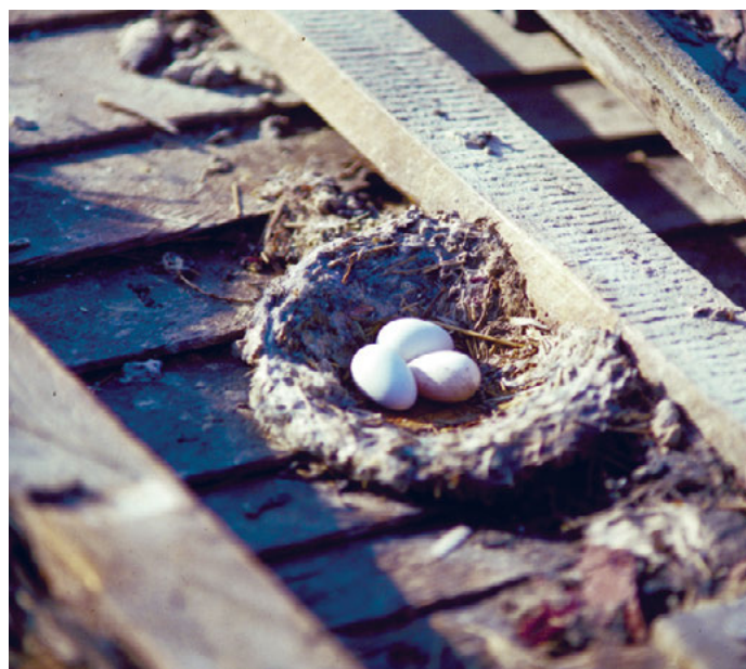
Nid typique de Martinet noir sur une sous-toiture.
