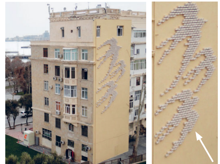
Nouvelle offre de nichoires pour les Martinets après la rénovation de la tour antique de Bakou. (Image: Atelier Erich Pummer GmbH).
