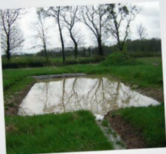
Un des nombreux systèmes de décantation
