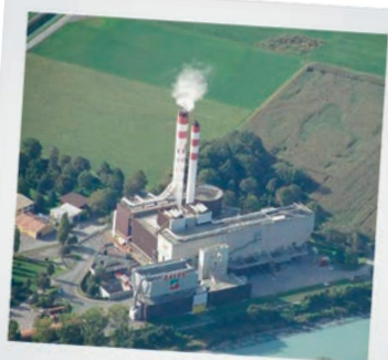
Une usine d'incinération
