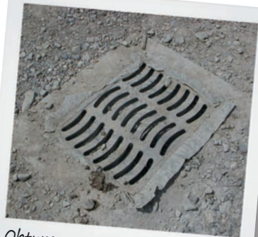
Obturer pour éviter que la boue ne parte dans les eaux claires
