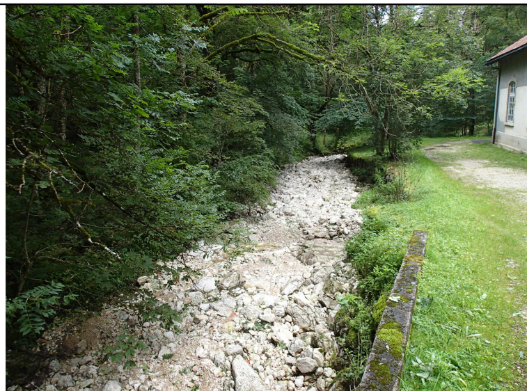
Vue direction aval du lit de la Rançonnière avec en rive droite l'usine de turbinage
