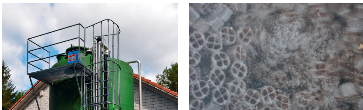
Figure 25 : Réacteur à lit fluidisé (à gauche) rempli de petits supports synthétiques (à droite).
