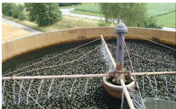
Figure 28: Procédé à lit bactérien (à gauche) et disques biologiques rotatifs (à droite).
