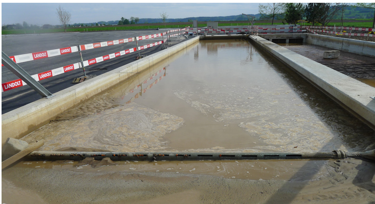
Figure 18 : Les eaux usées argileuses issues des installations de préparation des carottes sont difficiles à sédimenter.
