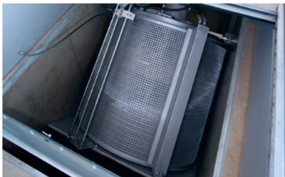
Figure 40 : Tamboeur de tamisage pour la séparation des matières solides (modèle Huber Picatech).
