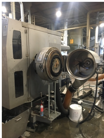
Extrusion (ligne arrêtée, entretien)
