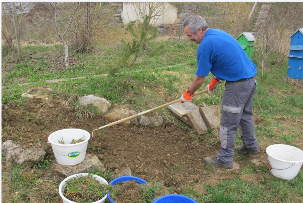
Préparation et pose de dalles pour un nouveau bout de chemin...
