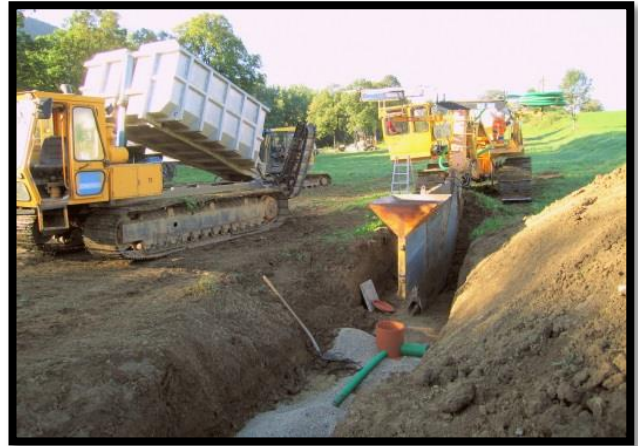
Travaux de drainages à Engollon (2011)
