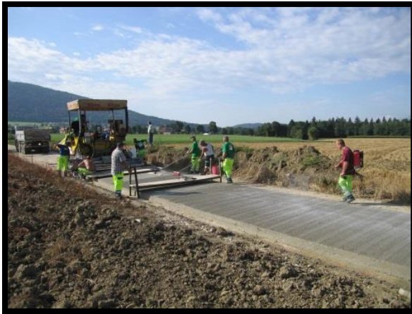
Bétonnage d'un chemin AF à Engollon (2012)
