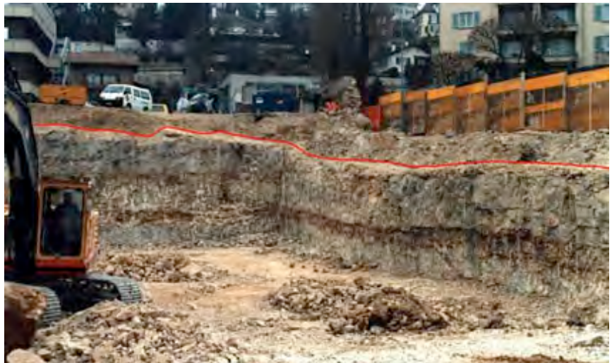
Figure 24 : Fouille du nouveau bâtiment CSEM
