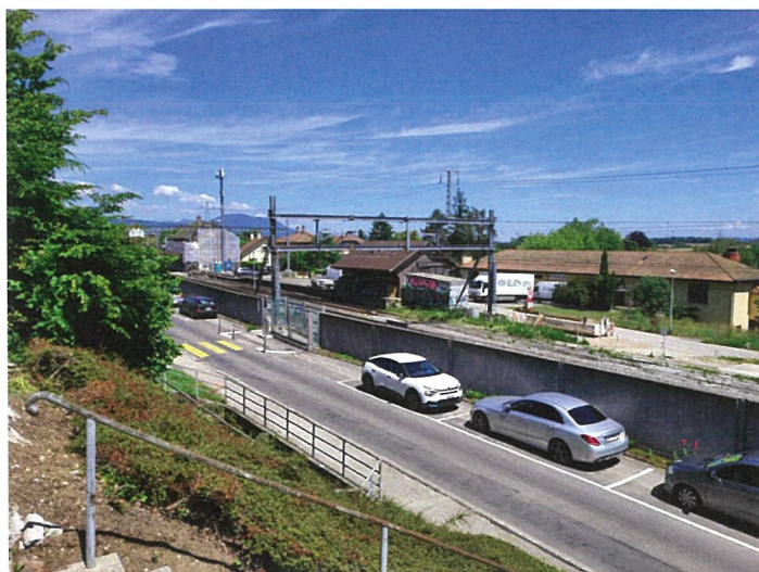
Vue en direction du Nord
