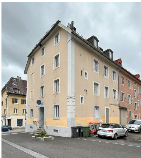
Vue depuis le Nord-Est
