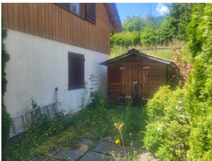
Façade Est / Nord-Est, cabane de jardin
