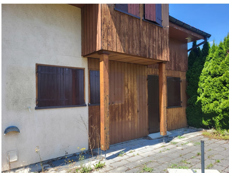
Façade Est / Sud-Est
