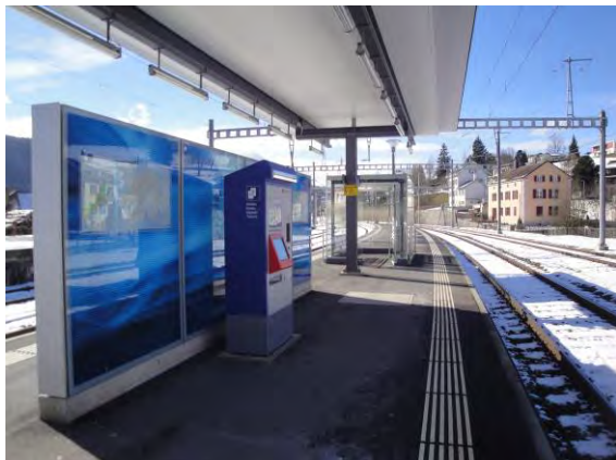
Infrastructures d'accueil, gare de Travers
