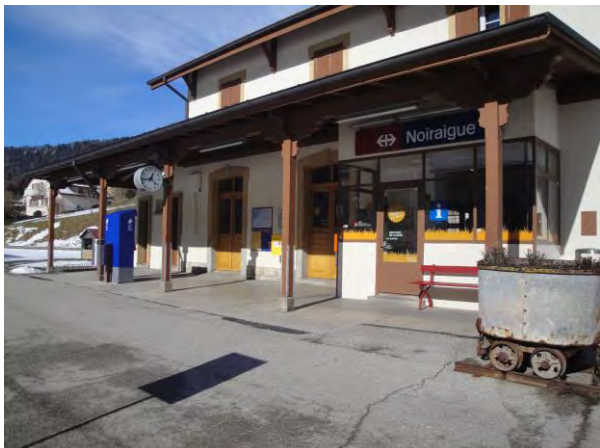
Infrastructures d'accueil, gare de Noiraigue
