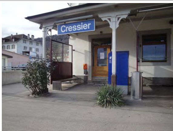
Infrastructures d'accueil, gare de Cressier
