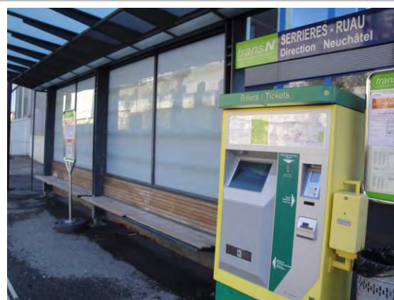
Infrastructures d'accueil, halte de Serrières-Ruau
