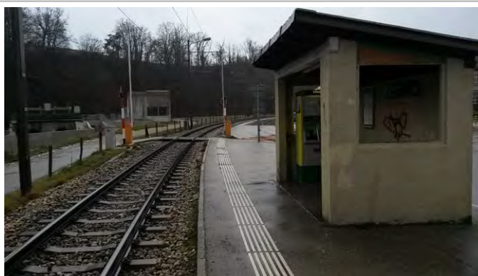
Infrastructures d'accueil, halte Tuirière
