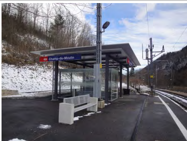
Infrastructures d'accueil, gare de Champ-du-Moulin
