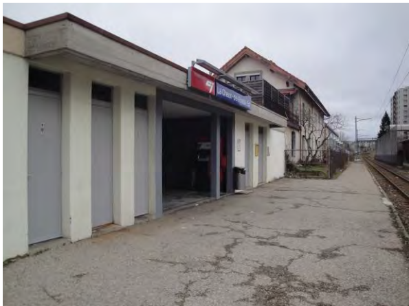
Infrastructures d'accueil, halte La Chaux-de-Fonds Est
