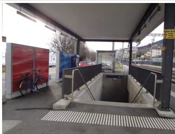
Infrastructures d'accueil, gare de St-Blaise CFF
