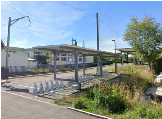
Infrastructures d'accueil, gare des Forges
