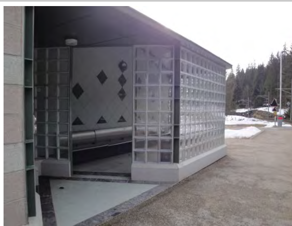
Infrastructures d'accueil, halte de La Corbatière
