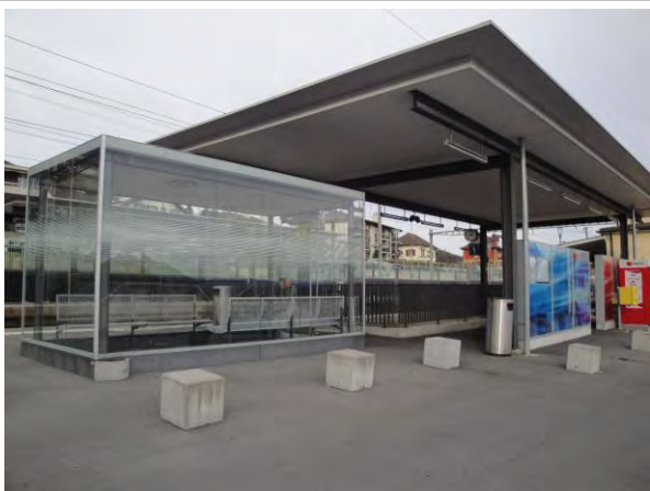
Infrastructures d'accueil, gare de St-Blaise CFF
