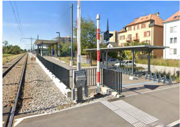
Infrastructures d'accueil, gare des Forges
