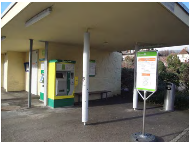
Infrastructures d'accueil, halte d'Auvernier Littorail
