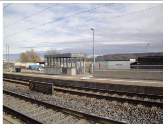
Infrastructures d'accueil, gare de Cressier
