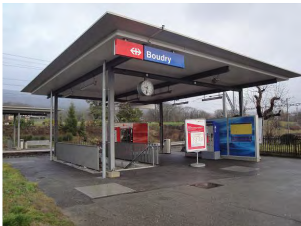
Infrastructures d'accueil, gare de Boudry
