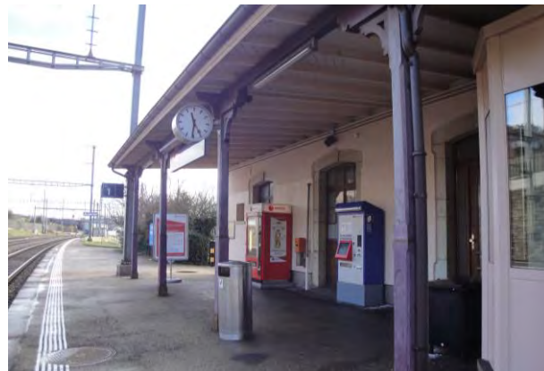
Infrastructure d'accueil, gare d'Auvernier
