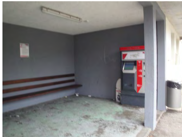
Infrastructures d'accueil, halte La Chaux-de-Fonds Est
