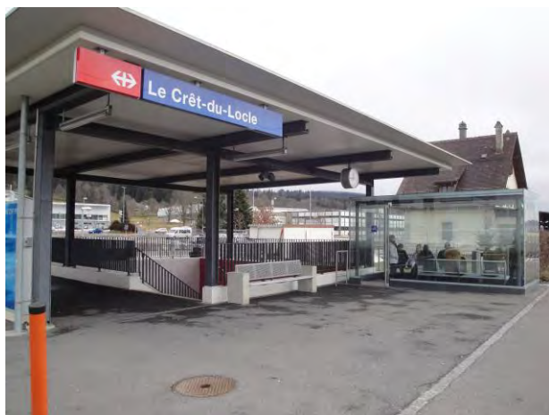
Infrastructures d'accueil, halte du Crêt-du-Loche
