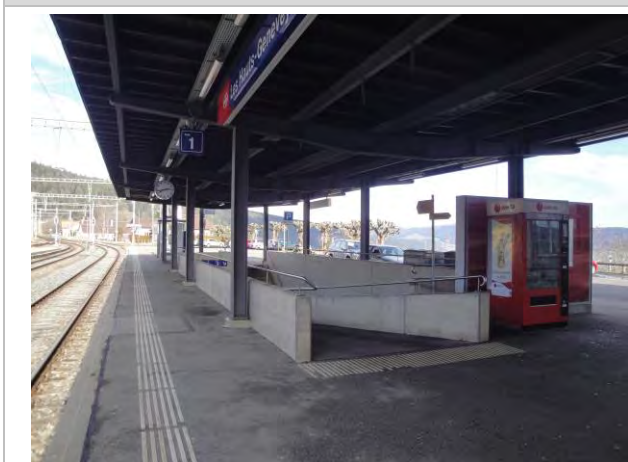
Infrastructures d'accueil, gare des Hauts-Geneveys
