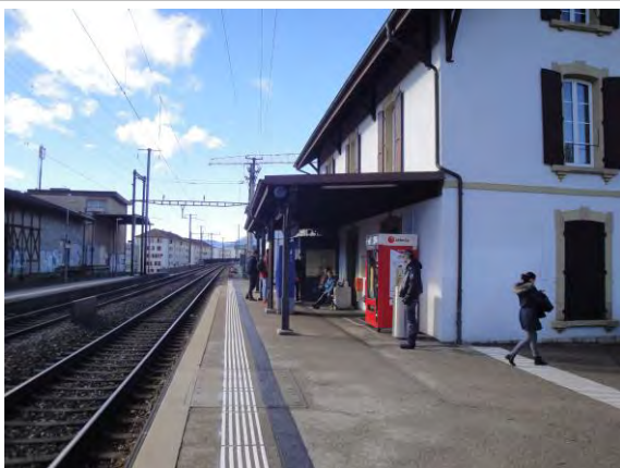
Infrastructures d'accueil, halte de Neuchâtel-Serrières
