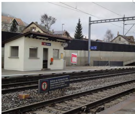
Espace d'attente fermée, gare de Bevaix
