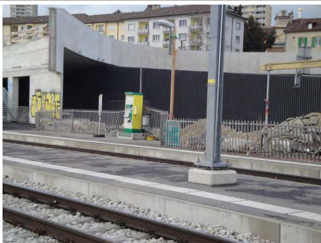
Infrastructures d'accueil, halte de Port-de-Serrières
