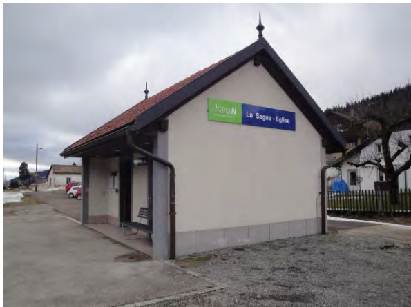
Infrastructures d'accueil, halte de la Sagne-Eglise
