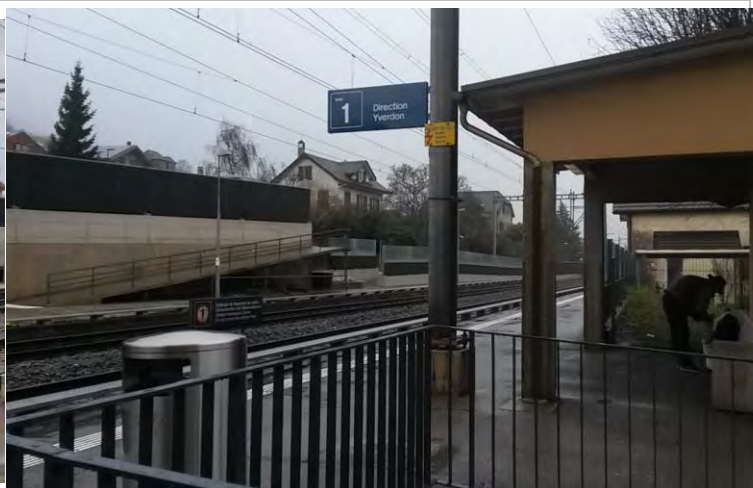
Infrastructures d'accueil, gare de Bevaix
