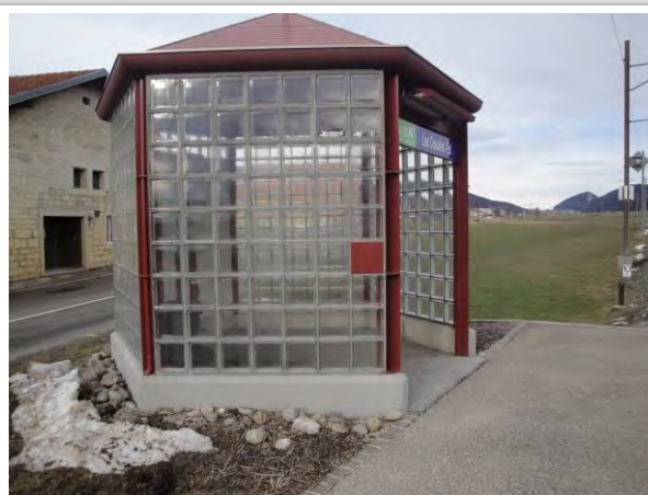
Infrastructures d'accueil, halte des Coeudres-Est
