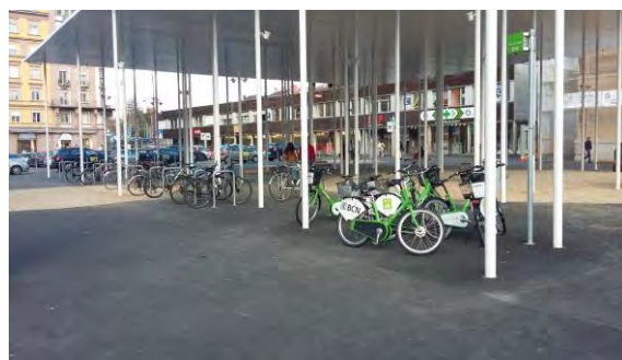
Station VLS, gare de La Chaux-de-Fonds
