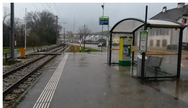
Infrastructures d'accueil, halte des Islles Littorail
