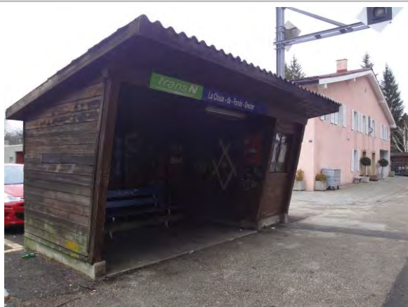
Infrastructures d'accueil, halte de La Chaix-de-Fonds Grenier
