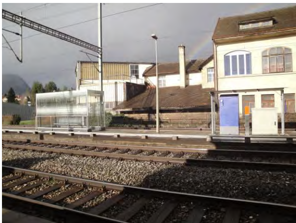
Infrastructures d'accueil, gare de Colombier
