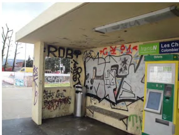
Infrastructures d'accueil, halte des Chézards
