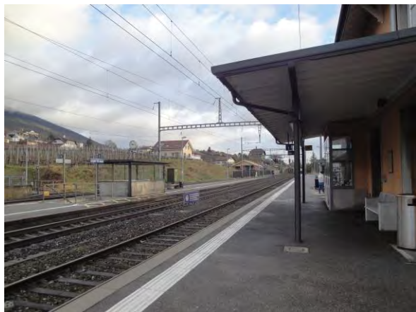
Infrastructures d'accueil, gare de Gorgier St-Aubin
