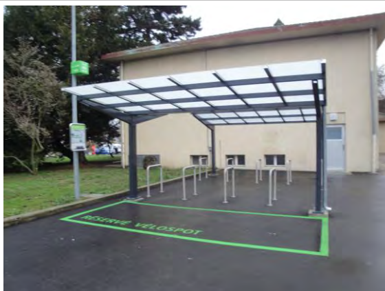
Infrastructures d'accueil, halte de Boudry Littorail
