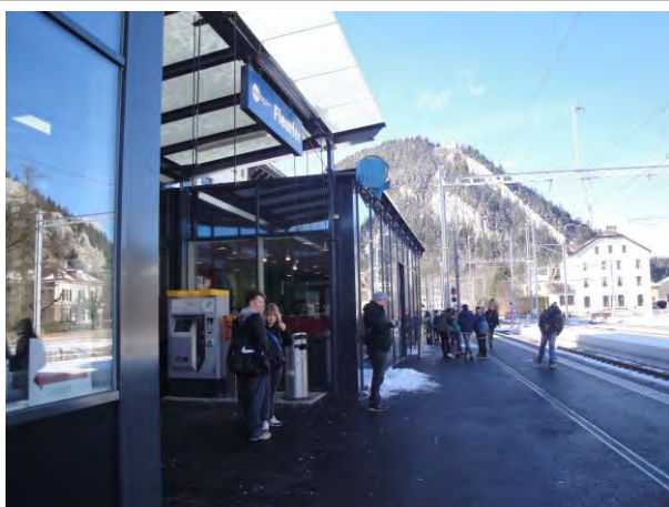
Infrastructures d'accueil, gare de Fleurier
