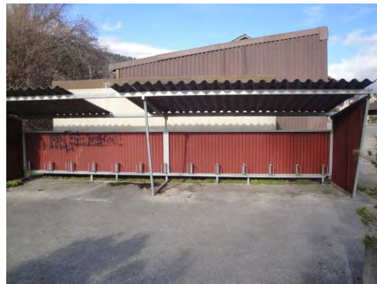
Offre en stationnement vélo, gare des Geneveys-sur-Coffrane
