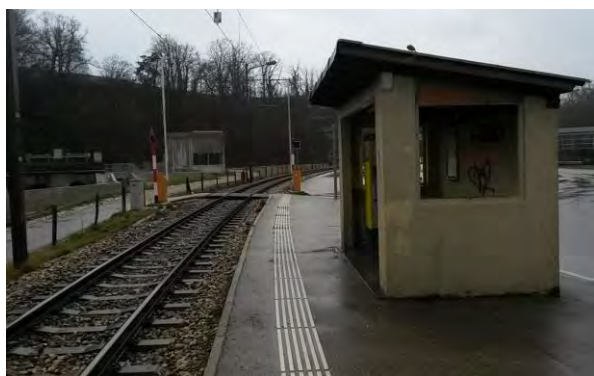
Infrastructures d'accueil, halte Tuirière
