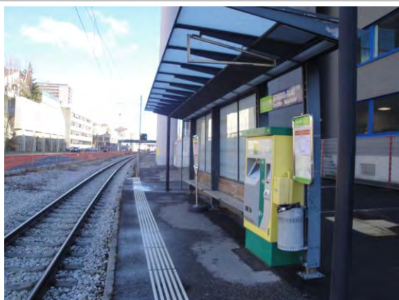
Infrastructures d'accueil, halte de Serrières-Ruau
