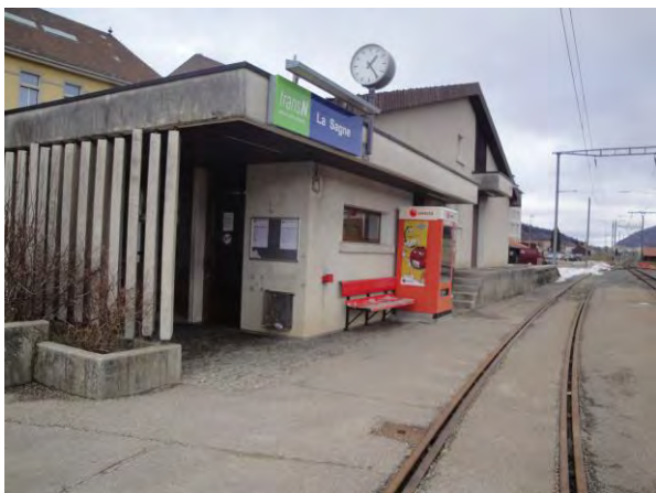
Infrastructures d'accueil, halte de la Sagne
