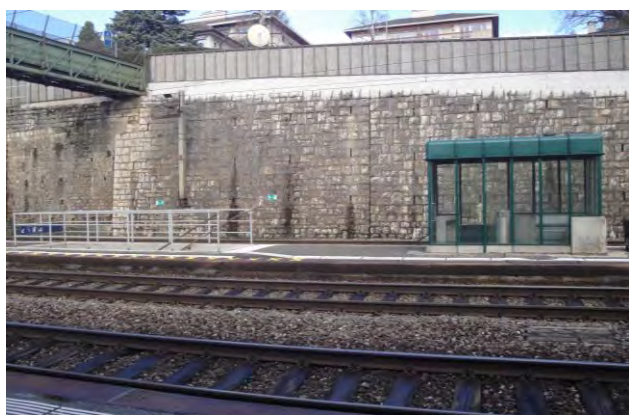
Passage sur-voie et espace d'attente fermé, gare d'Auvernier
