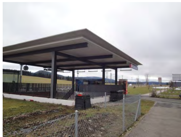
Infrastructures d'accueil, halte du Crêt-du-Loche
