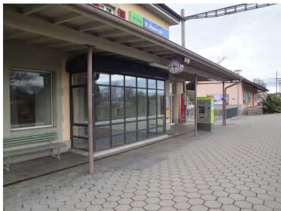
Infrastructures d'accueil, gare de St-Blaise Lac
