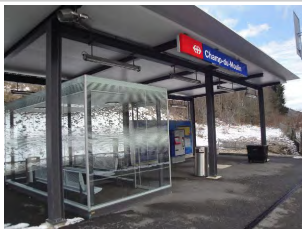
Infrastructures d'accueil, gare de Champ-du-Moulin
