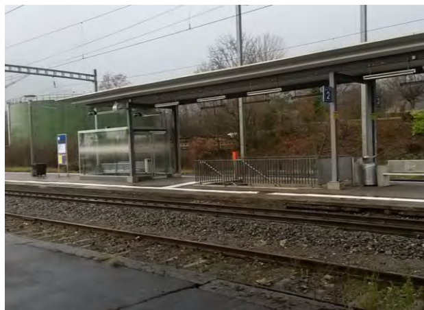
Offre en infrastructures, gare de Boudry
