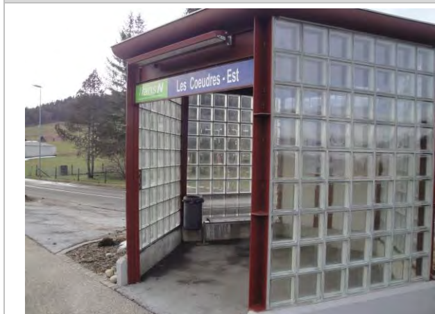
Infrastructures d'accueil, halte des Coeudres-Est
