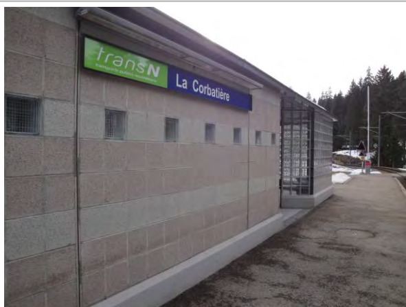
Infrastructures d'accueil, halte de La Corbatière
