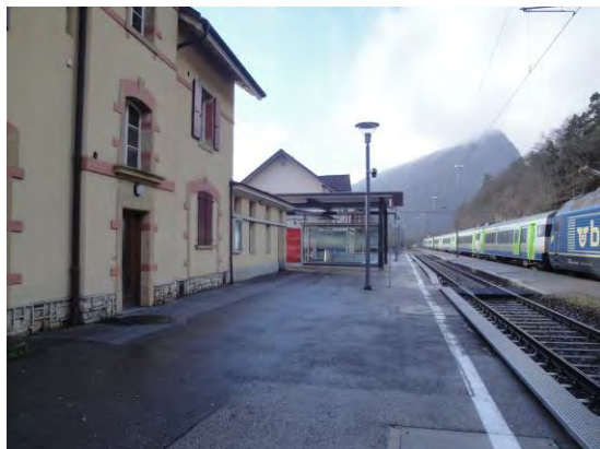
Infrastructures d'accueil, gare de Chambrelieu
