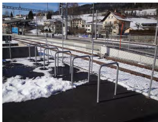
Offre en stationnement vélo, gare de Travers
