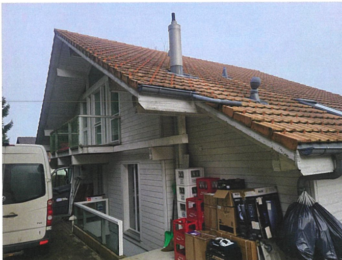
Vue d'ensemble, angle Nord-Ouest
