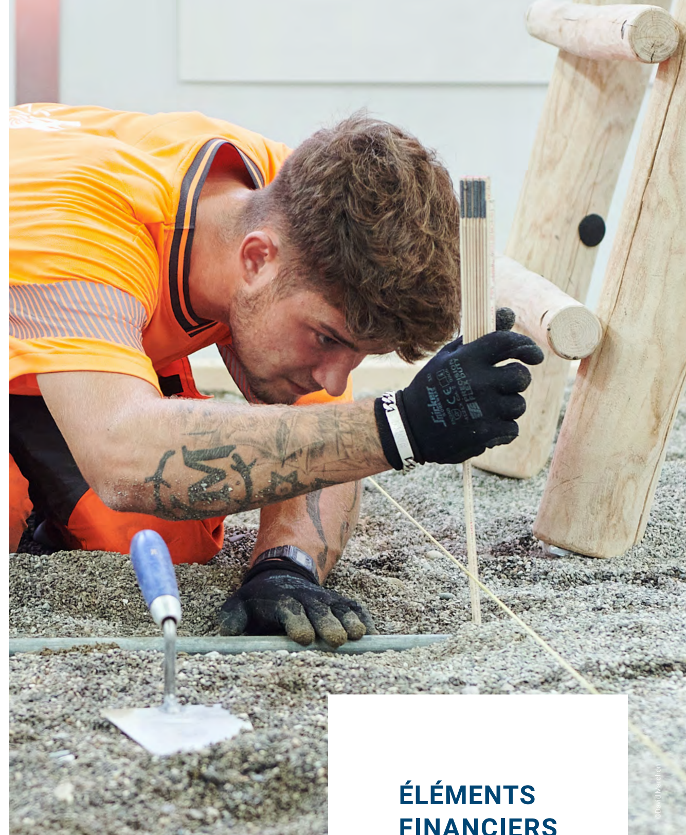
Maçon CFC / Maçonne CFC
