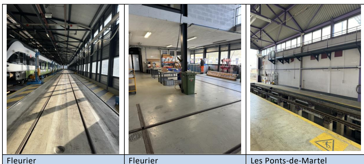
Figure 5 : Ateliers ferroviaires de Fleurier et des Ponts-de-Martel
