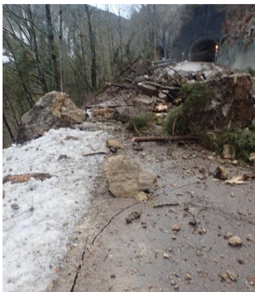
Figure 1 : Photo de l'éboulement du 7 février 2022 (source : bureau YBR) ayant touché la route cantonale H10 à St-Sulpice. On distingue les dépôts de débris et les dommages au niveau de la chaussée, en particulier les fissures en lien avec l'impact des blocs rocheux.
