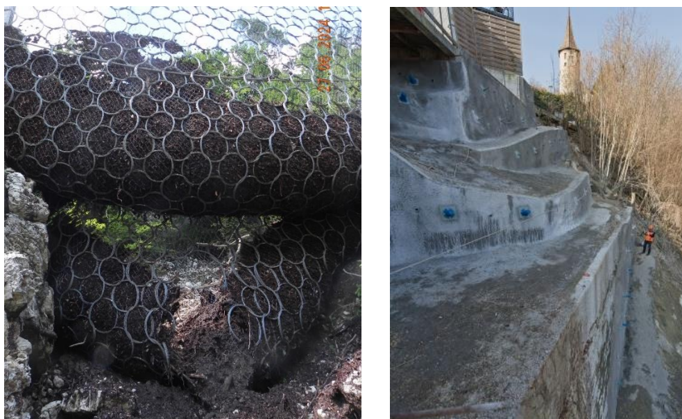
Figure 3 : À gauche, filet pare-pierres réalisé dans le cadre du projet de protection du village de Noiraigue, après le violent orage survenu le 26 juin 2024. L'ouvrage a permis d'arrêter les matériaux charriés par une crue le long de la Combe Hory, évitant ainsi qu'ils atteignent la H10. À droite, une partie de la paroi gunitée clouée à surveiller, réalisée pour la stabilisation du versant Marfaux et la sécurisation du vieux bourg de Boudry. La tour Marfaux est visible en arrière-plan.
