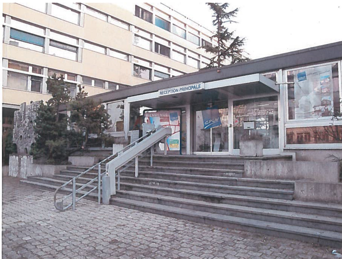
Bâtiment ABn (nord)
