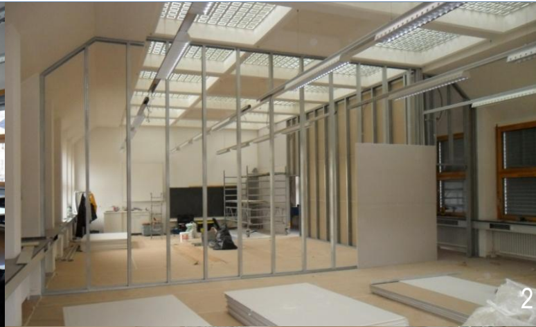
2. Montage d'une cloison légère « Rigips » 4. Réparation du parquet de la salle 425
