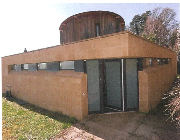
FACADE NORD-EST / ENTREE NORD
