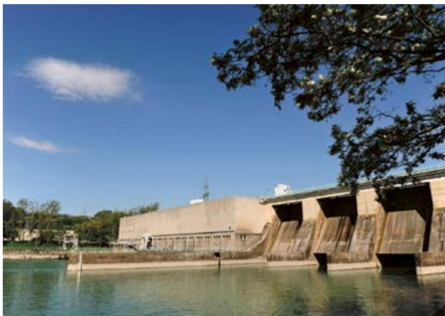
Principal ouvrage hydroélectrique du Rhône genevois, le barrage de Verbois, propriété de SIG, a été inauguré en 1944. Sa construction aura nécessité 131'000 m<sup>3</sup> de béton et 37'500 m<sup>3</sup> de ciment, soit presque 19 fois le volume de la pyramide du Louvre. Cet aménagement comprend quatre passes, chacune ayant deux vannes, l'usine à proprement parler avec quatre turbines Kaplan et deux digues latérales.
