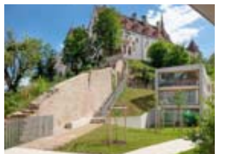
Ce mur est l'un des derniers restes des fortifications médiévales de Neuchâtel. VVES ANDRÉ
