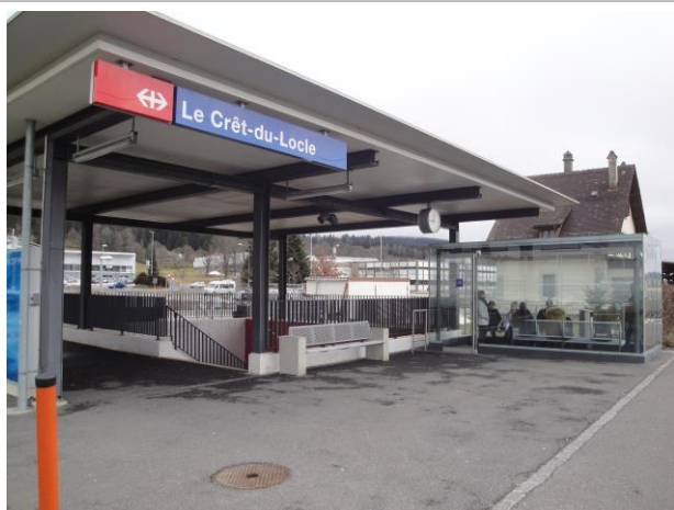
Infrastructures d'accueil, halte du Crêt-du-Loche
