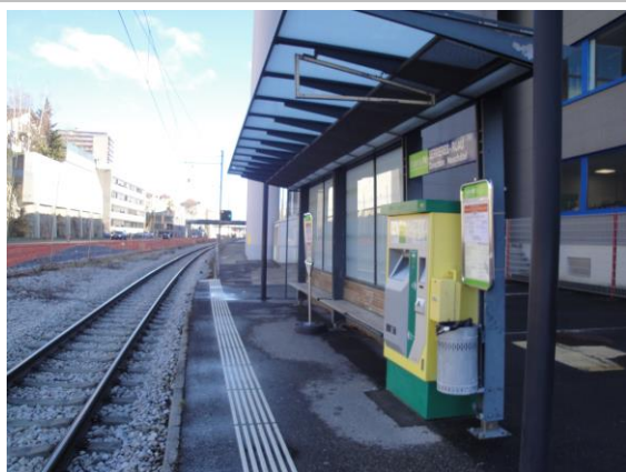
Infrastructures d'accueil, halte de Serrières-Ruau
