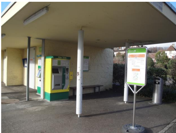
Infrastructures d'accueil, halte d'Auvernier Littorail
