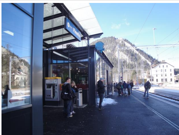
Infrastructures d'accueil, gare de Fleurier
