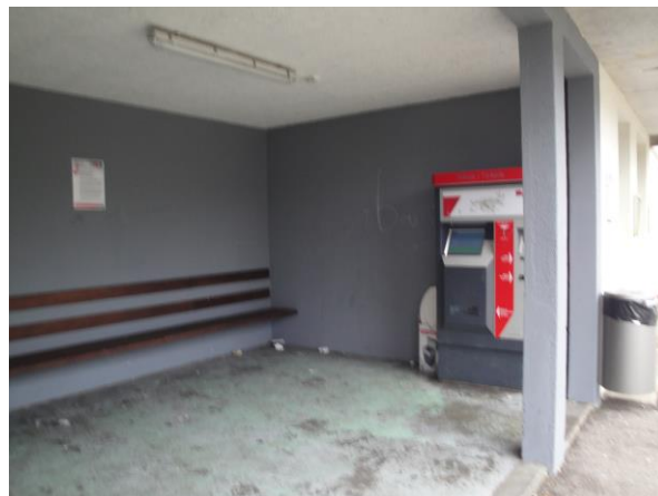
Infrastructures d'accueil, halte La Chaux-de-Fonds Est
