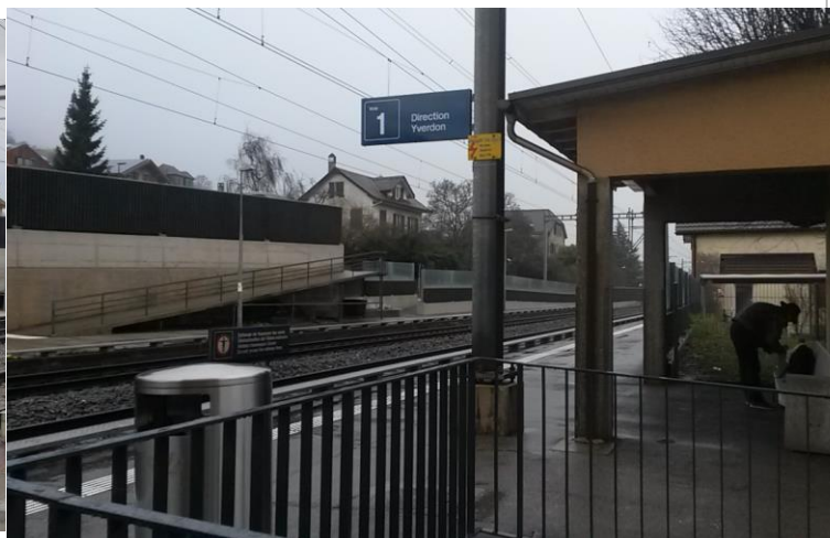
Infrastructures d'accueil, gare de Bevaix
