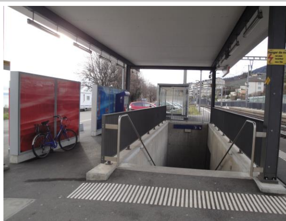
Infrastructures d'accueil, gare de St-Blaise CFF
