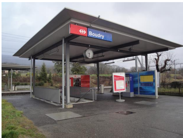
Infrastructures d'accueil, gare de Boudry
