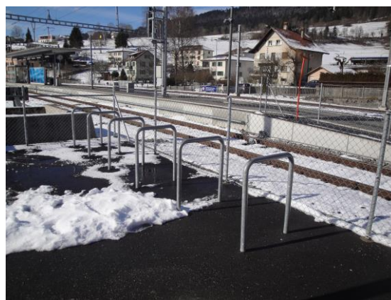
Offre en stationnement vélo, gare de Travers
