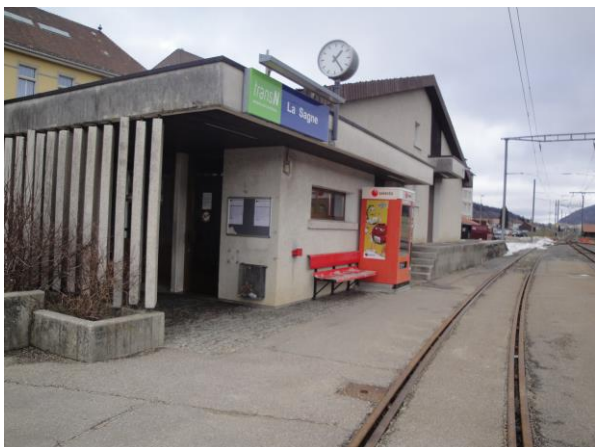
Infrastructures d'accueil, halte de la Sagne
