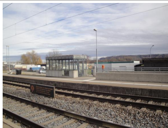
Infrastructures d'accueil, gare de Cressier
