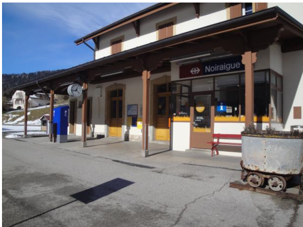
Infrastructures d'accueil, gare de Noiraigue
