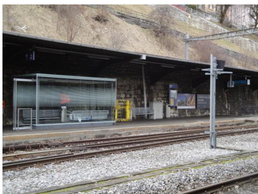
Infrastructures d'accueil, gare du Locle
