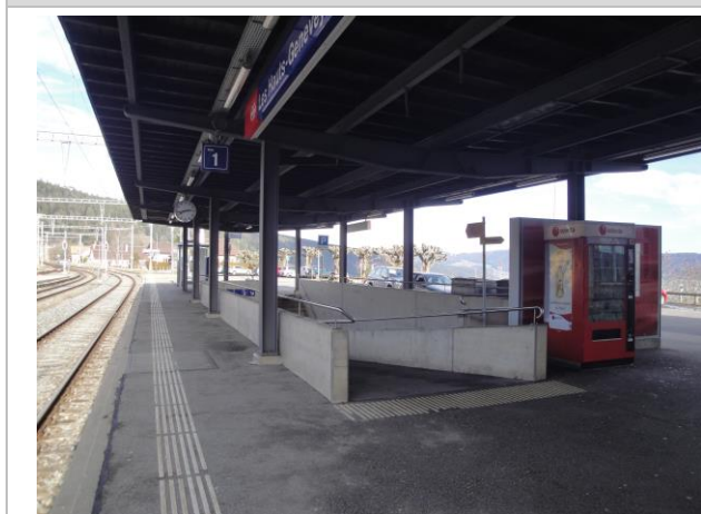
Infrastructures d'accueil, gare des Hauts-Geneveys
