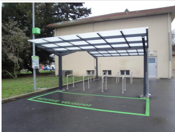
Infrastructures d'accueil, halte de Boudry Littorail
