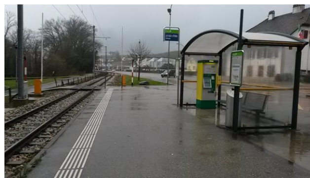
Infrastructures d'accueil, halte des Isles Littorail
