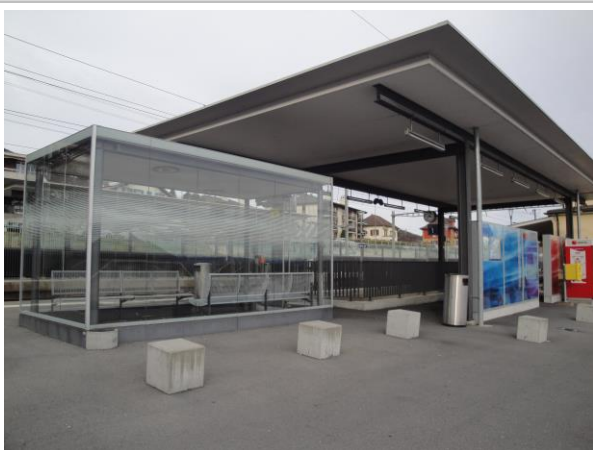
Infrastructures d'accueil, gare de St-Blaise CFF
