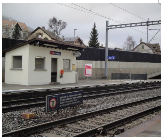
Espace d'attente fermée, gare de Bevaix
