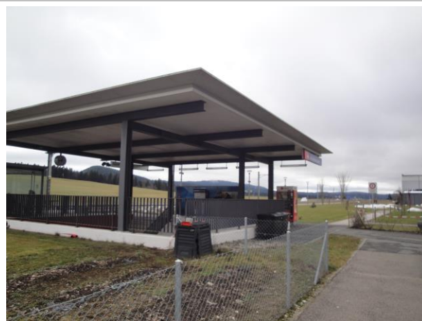
Infrastructures d'accueil, halte du Crêt-du-Loche
