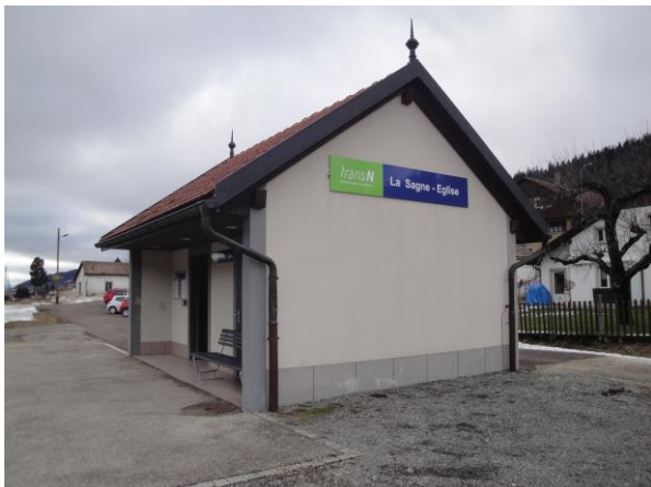
Infrastructures d'accueil, halte de la Sagne-Eglise
