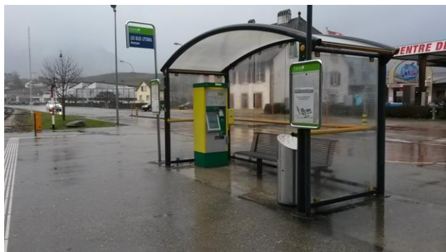
Infrastructures d'accueil, halte des Isles Littorail
