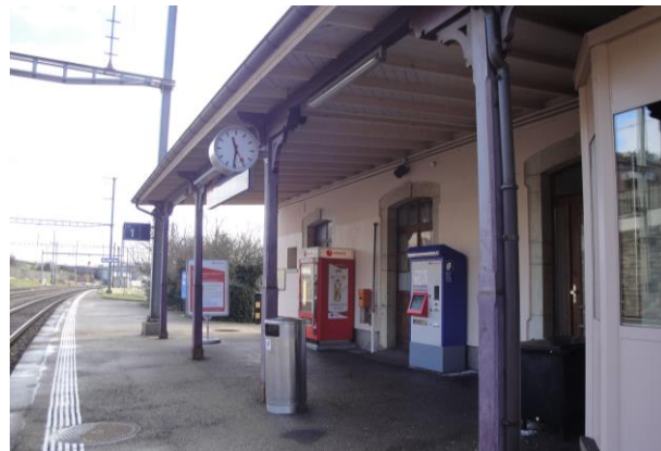
Infrastructure d'accueil, gare d'Auvernier
