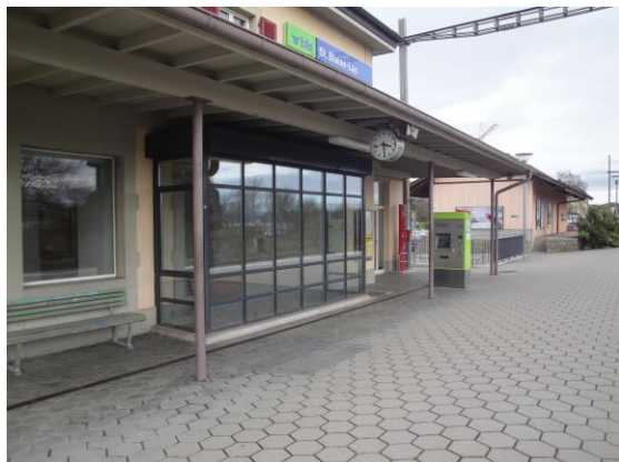
Infrastructures d'accueil, gare de St-Blaise Lac
