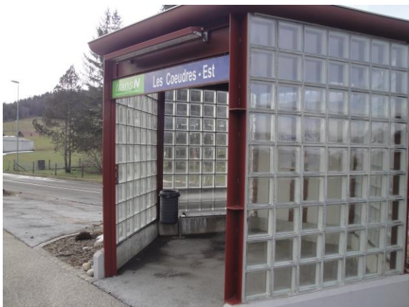
Infrastructures d'accueil, halte des Coeudres-Est
