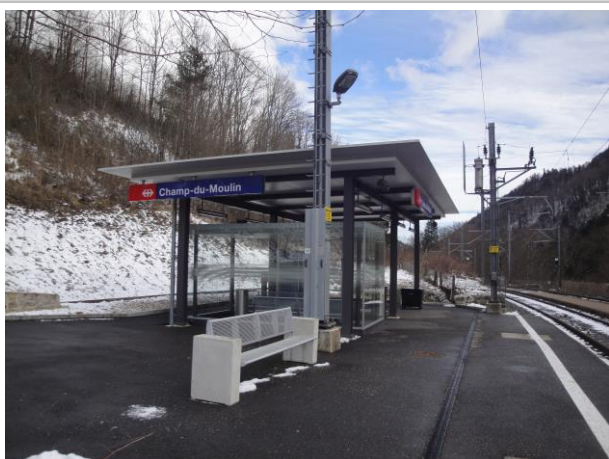
Infrastructures d'accueil, gare de Champ-du-Moulin
