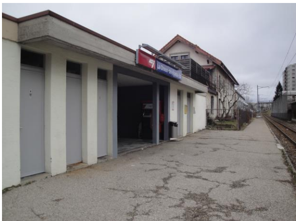
Infrastructures d'accueil, halte La Chaux-de-Fonds Est
