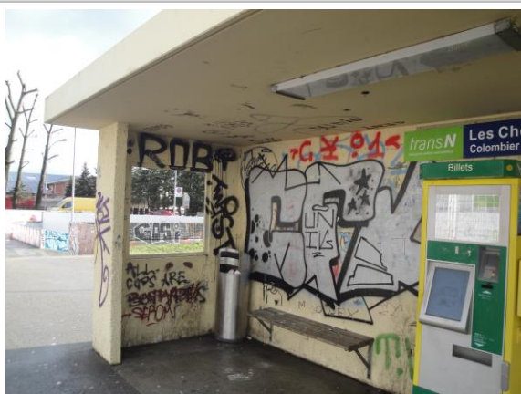
Infrastructures d'accueil, halte des Chézards
