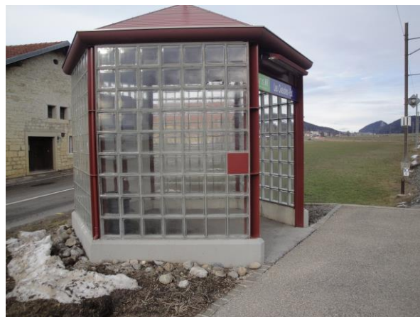
Infrastructures d'accueil, halte des Coeudres-Est
