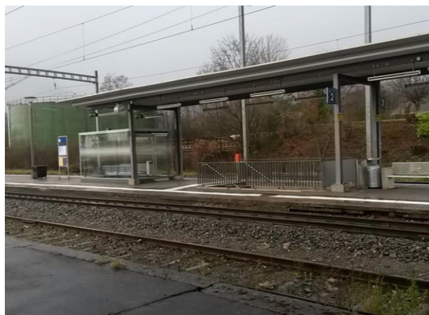
Offre en infrastructures, gare de Boudry
