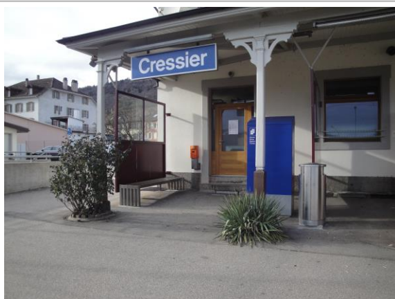
Infrastructures d'accueil, gare de Cressier
