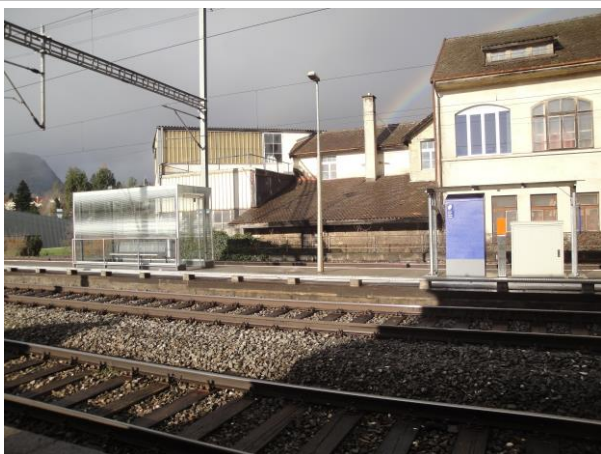
Infrastructures d'accueil, gare de Colombier
