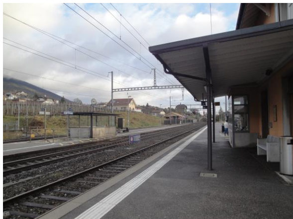
Infrastructures d'accueil, gare de Gorgier St-Aubin
