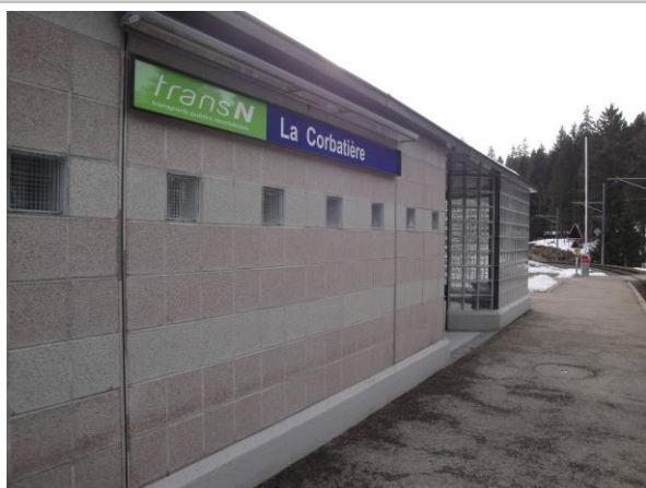
Infrastructures d'accueil, halte de La Corbatière
