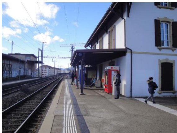
Infrastructures d'accueil, halte de Neuchâtel-Serrières
