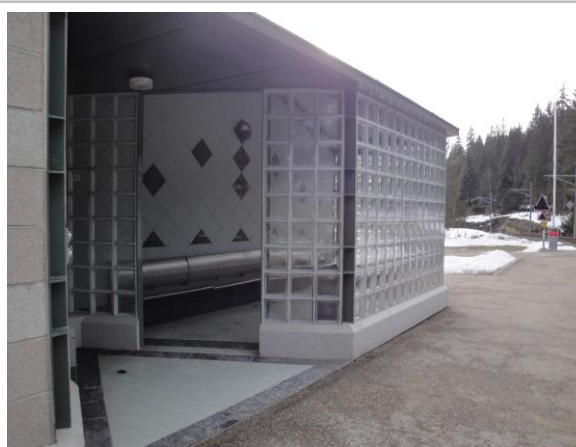
Infrastructures d'accueil, halte de La Corbatière
