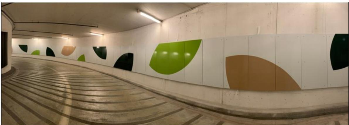
Figure 8 : Exemple d'installation de panneaux thermiques (Enerdrape, 2023).
