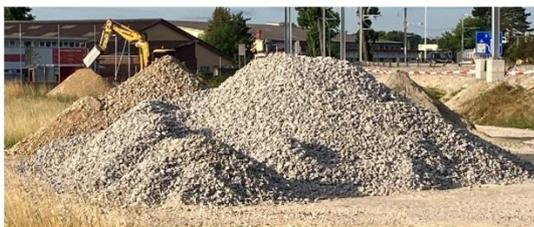
a) Roches concassées et graves de taille 32-50 et 4-32 mm pour la stabilisation et le remblayage constructif dans le cadre d'un chantier.
