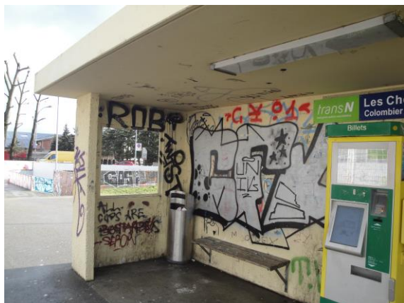
Infrastructures d'accueil, halte des Chézards
