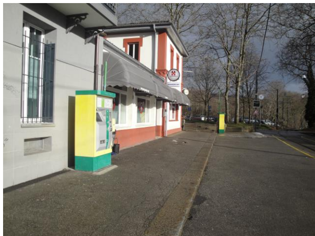
Infrastructures d'accueil, halte de Colombier Littorail
