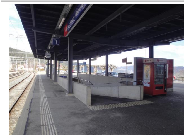
Infrastructures d'accueil, gare des Hauts-Geneveys
