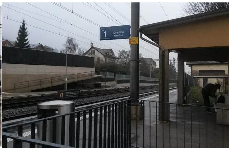
Infrastructures d'accueil, gare de Bevaix
