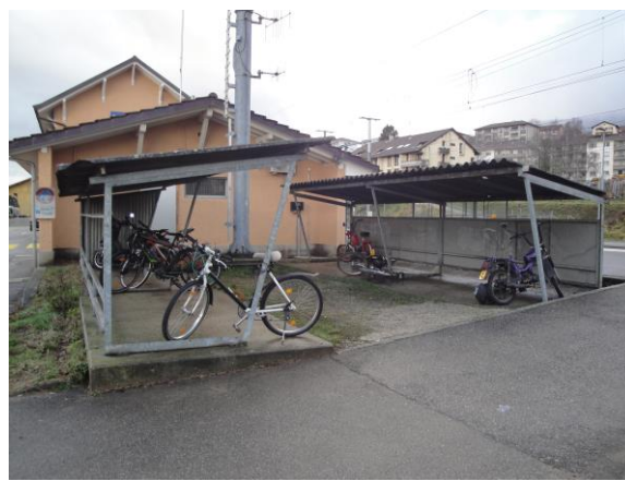
Offre en stationnement vélo, gare de Gorgier St-Aubin
