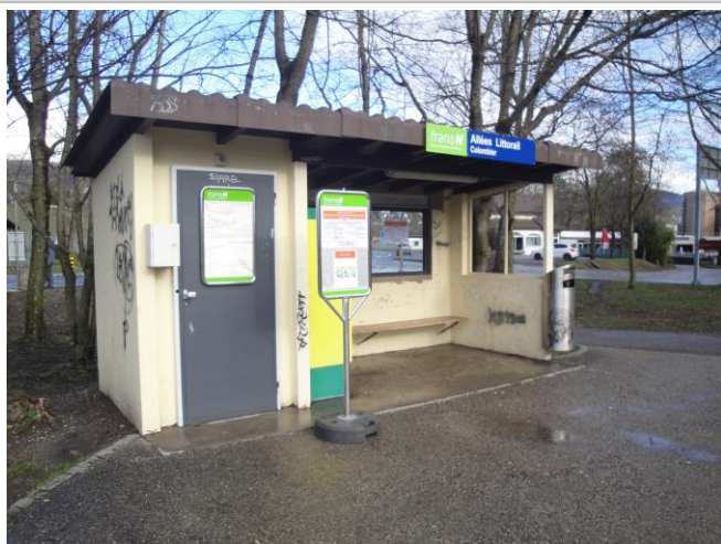
Infrastructures d'accueil, halte Allées Littorail
