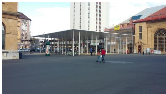
Parking vélo couvert, gare de La Chaux-de-Fonds
