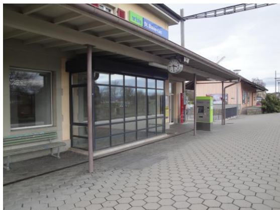
Infrastructures d'accueil, gare de St-Blaise Lac
