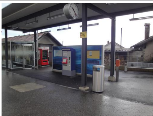
Infrastructures d'accueil, halte de Bôle
