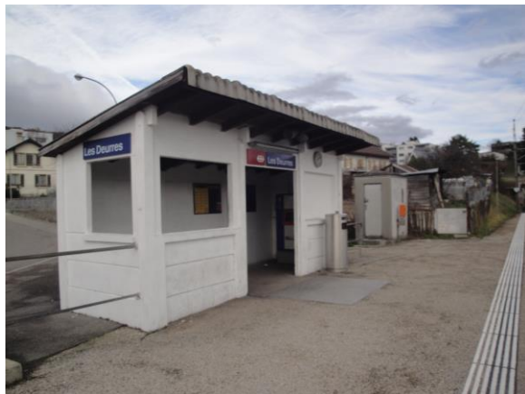
Infrastructures d'accueil, halte des Deurres
