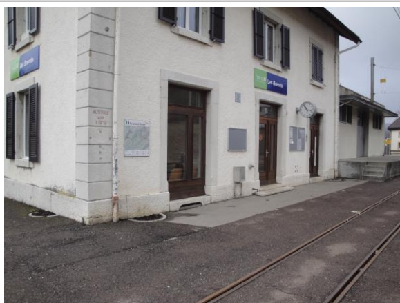
Infrastructures d'accueil, gare des Brenets
