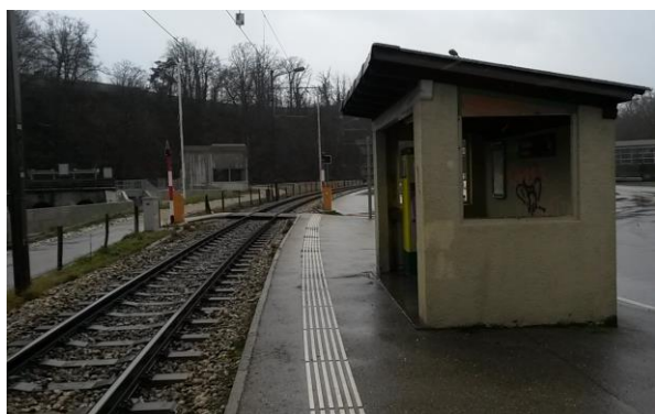
Infrastructures d'accueil, halte Tuirière
