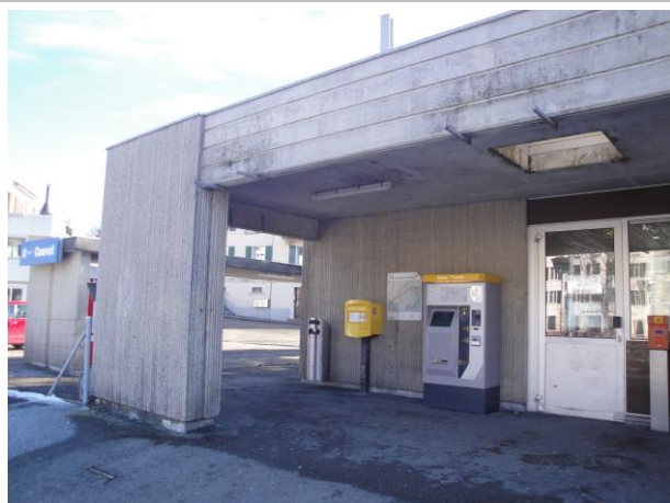
Infrastructures d'accueil, gare de Couvet
