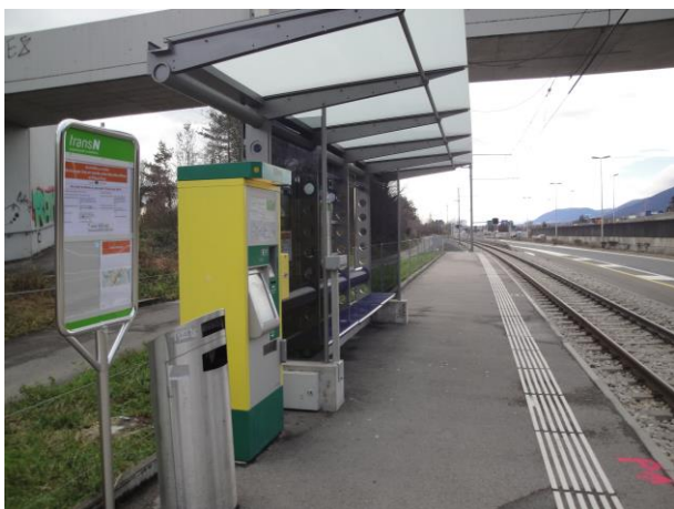
Infrastructures d'accueil, halte de Champ-Bougin
