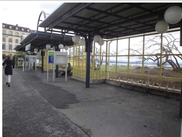
Infrastructures d'accueil, halte Place Pury Littorail
