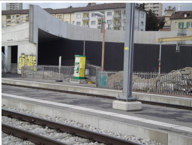
Infrastructures d'accueil, halte de Port-de-Serrières
