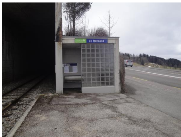
Infrastructures d'accueil, halte du Reymond
