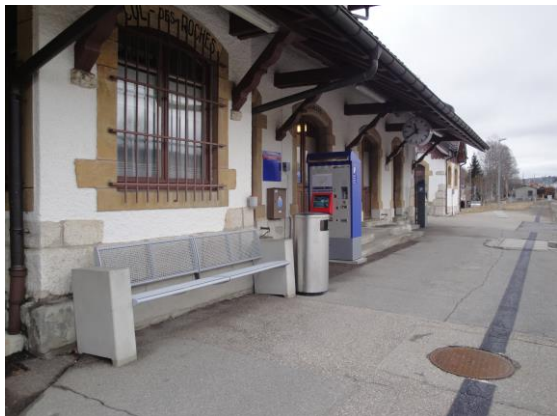
Infrastructures d'accueil, halte du Locle-Col-des-Roches
