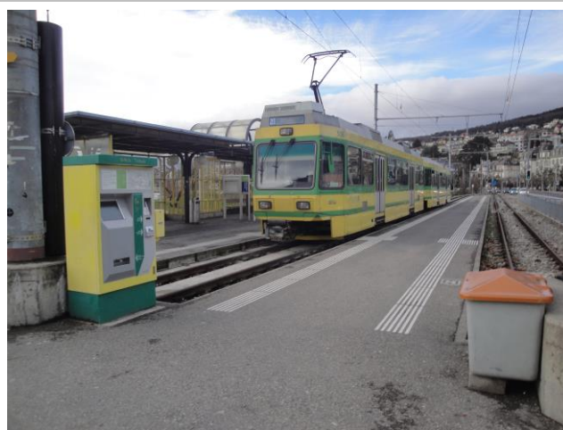
Infrastructures d'accueil, halte Place Pury Littorail
