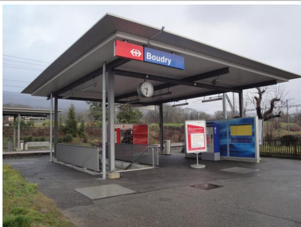
Infrastructures d'accueil, gare de Boudry
