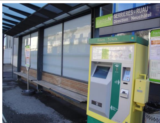
Infrastructures d'accueil, halte de Serrières-Ruau
