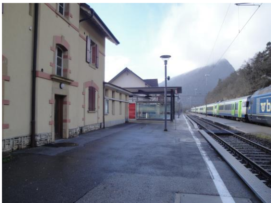
Infrastructures d'accueil, gare de Chambrelieu
