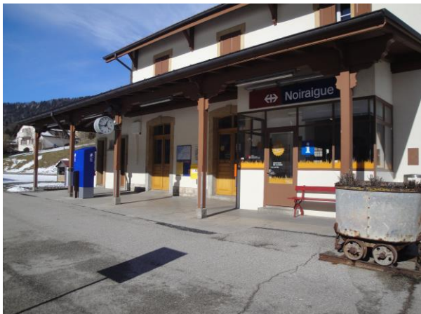
Infrastructures d'accueil, gare de Noiraigue
