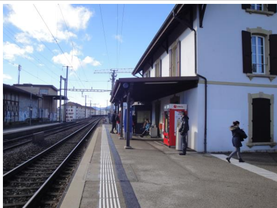
Infrastructures d'accueil, halte de Neuchâtel-Serrières
