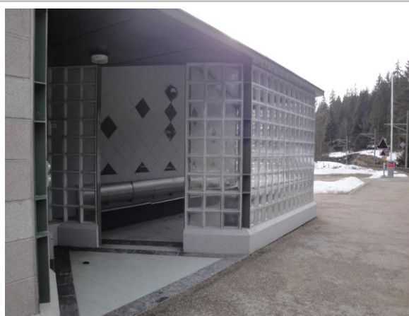
Infrastructures d'accueil, halte de La Corbatière
