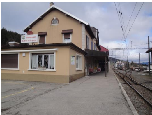
Infrastructures d'accueil, gare des Ponts-de-Martel
