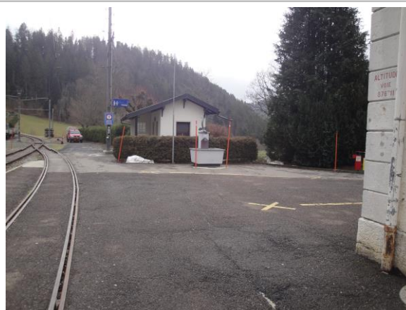
Infrastructures d'accueil, gare des Brenets
