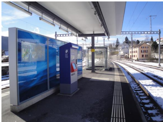
Infrastructures d'accueil, gare de Travers
