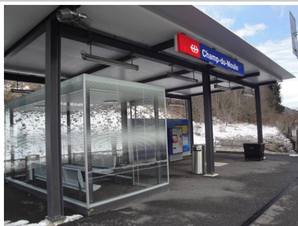
Infrastructures d'accueil, gare de Champ-du-Moulin
