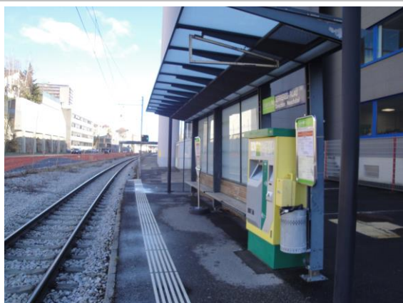
Infrastructures d'accueil, halte de Serrières-Ruau
