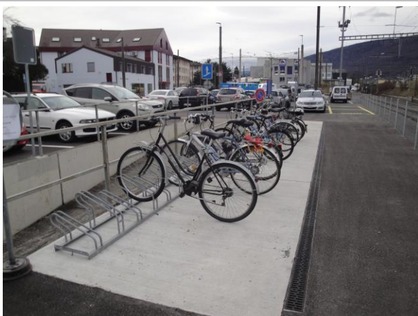
Nouvelle offre en stationnement vélo, gare (sud) de Marin-Epagnier (photo prise avant la pose de l'abri-vélos)
