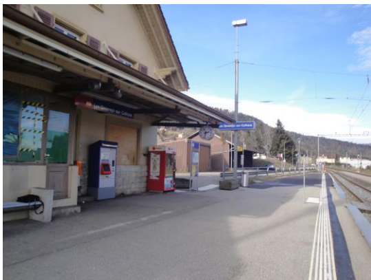
Infrastructures d'accueil, gare des Geneveys-sur-Coffrane
