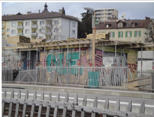
Infrastructures d'accueil, halte de Port-de-Serrières
