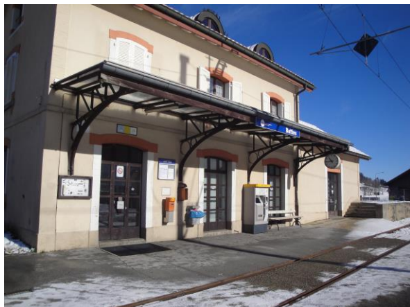
Bâtiment de la gare, halte de Buttes
