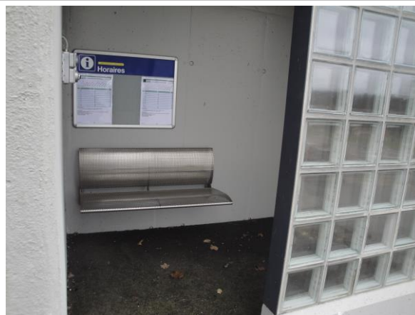
Infrastructures d'accueil, halte du Reymond
