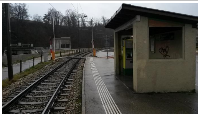
Infrastructures d'accueil, halte Tuirière
