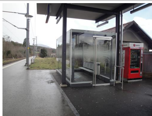
Infrastructures d'accueil, halte de Bôle
