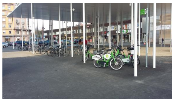
Station VLS, gare de La Chaux-de-Fonds
