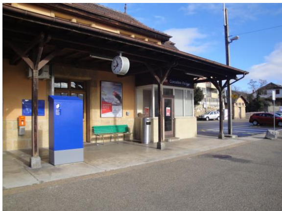
Infrastructures d'accueil, gare de Corcelles-Peseux
