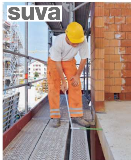
Règle 5 Contrôler les échafaudages.
