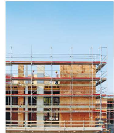
Règle 4 Travailler avec un échafaudage de façade.
