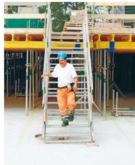
Règle 6 Installer des accès sûrs.
