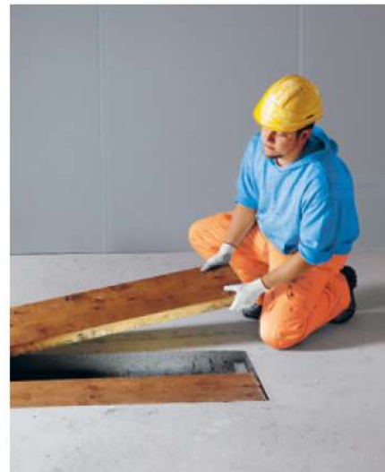
Règle 2 Sécuriser les ouvertures dans les sols.
