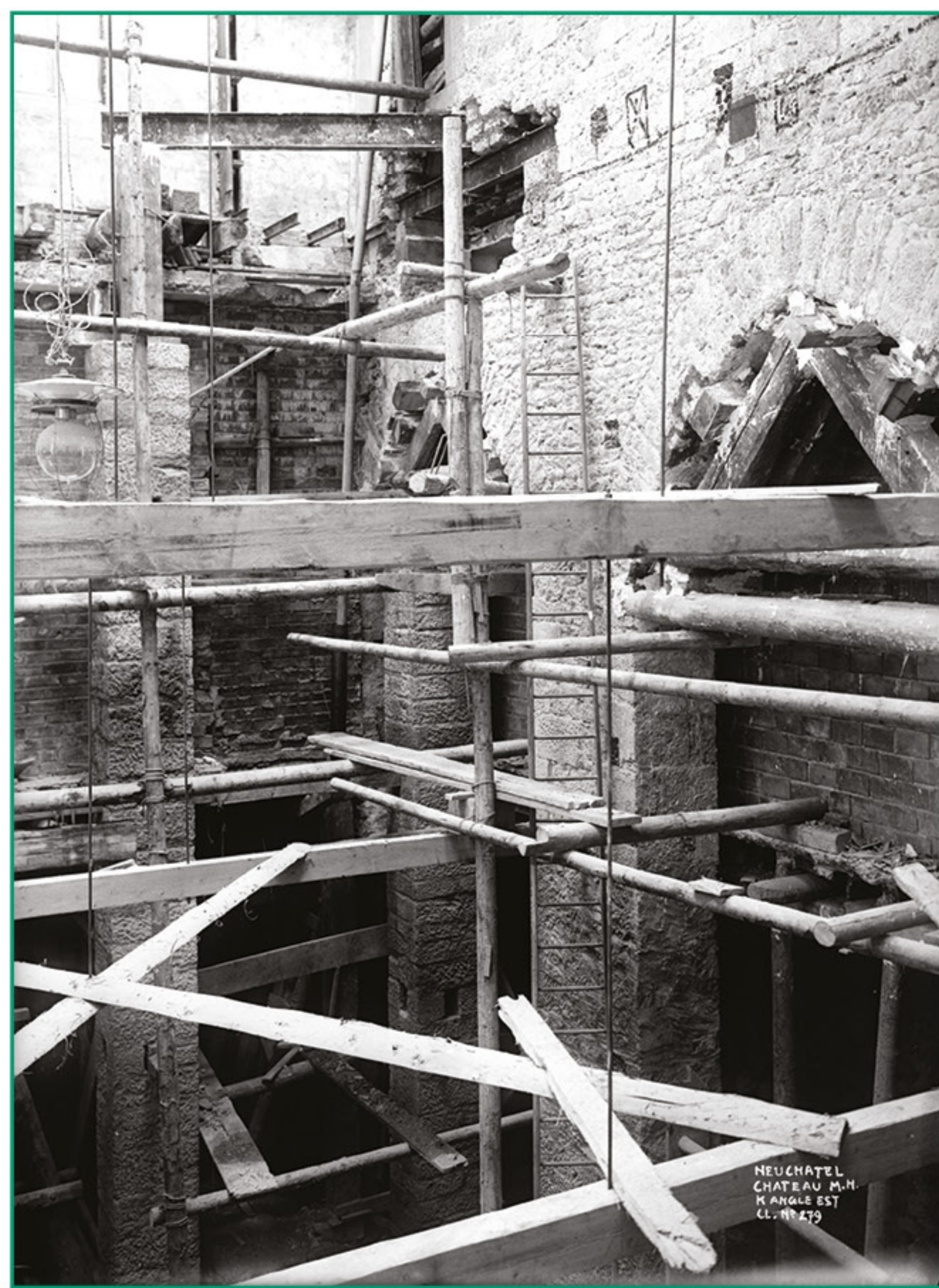
De nouveaux piliers sont édifiés sous la façade intérieure du portique est, la petite cour intérieure étant presque entièrement « comblée » au terme des travaux. (OPAN, fonds ISCP n°279, 1910)
