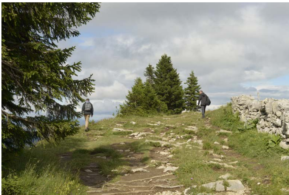
Figure 3 : secteur aménageable : aménagement du sentier sur la droite, et pose d'un géotextile et de piquets bas (espace suffisant pour la sécurité) (photos : SFFN, mai 2016)
