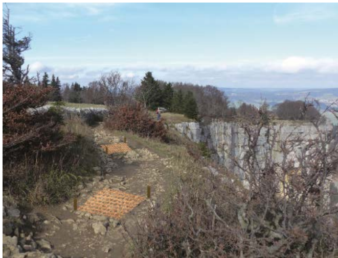
Figures 4 et 5 : Pose de géotextile (natte de coco) (EcoEng, mars 2016)
