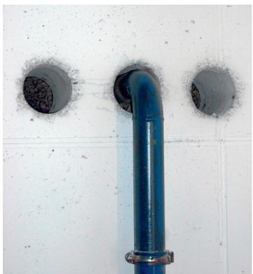
Les ouvertures et les fissures importantes dans les parties du bâtiment en contact avec le terrain doivent être obturées.
