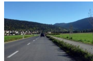
Figure 8 – Site propre MD le long de la rte du Seyon au Val-de-Ruz
