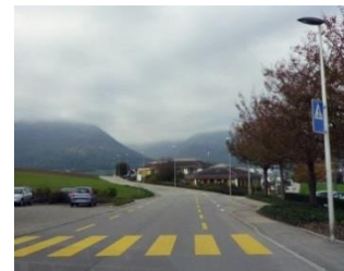
Figure 5 – Bandes cyclables sur la rte de Boudry à Cortaillod
